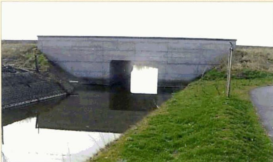
La ligne 73 fut déplacée afin de pouvoir supprimer les anciens passages à niveau. Pour ce faire, un nouveau pont dut être construit à +/- 400 m de l'ancien, toujours sur le "Vlavaart", qui est en fait un ruisseau de drainage. Photo Infrabel / SNCB, 1996.
