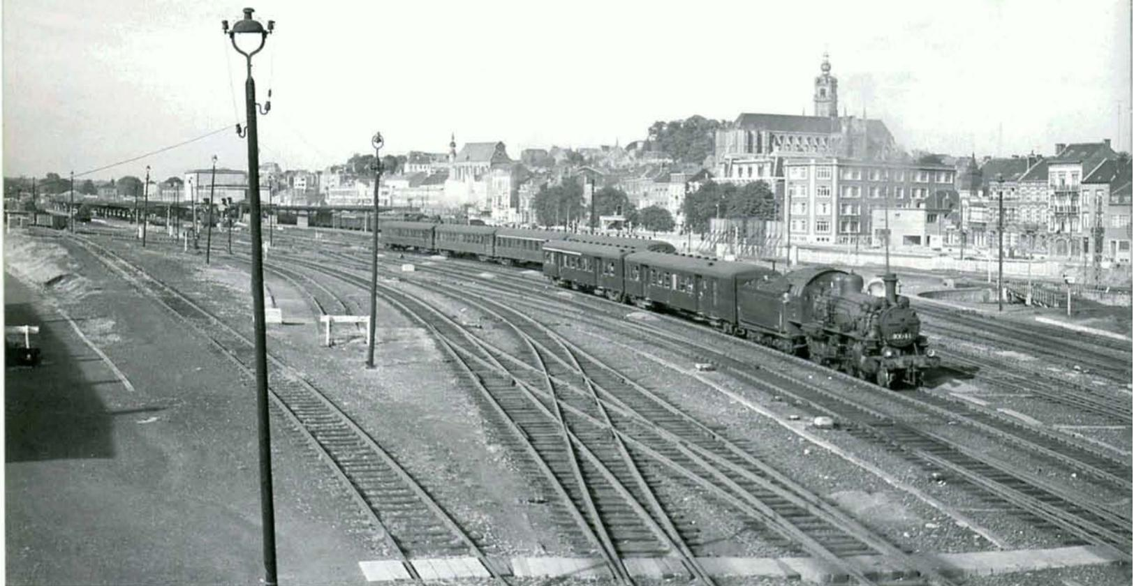
**PHOTO BD-11102** Le 7 juin 1959, départ d'un omnibus tracté par la 40.044 du dépôt de Mons. La photo est prise du "pont de Jemappes"; à droite, la plaque tournante située au pied du block 27 permet de virer les locomotives des trains reçus à la gare latérale. A l'arrière plan, la ville est dominée par la collégiale Ste-Waudru, le beffroi et le couvent des Ursulines.
