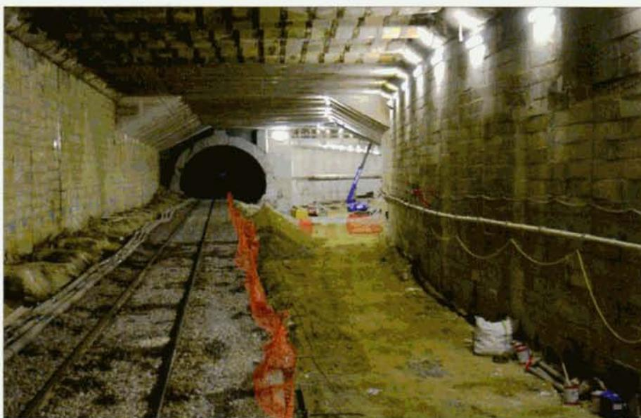
Le raccordement du tunnel Schuman-Josaphat dans le tunnel du Cinquantaire. La photo est prise en direction de Halle le 22 juillet. La voie de droite (vers Vilvoorde) est provisoirement démontée.
