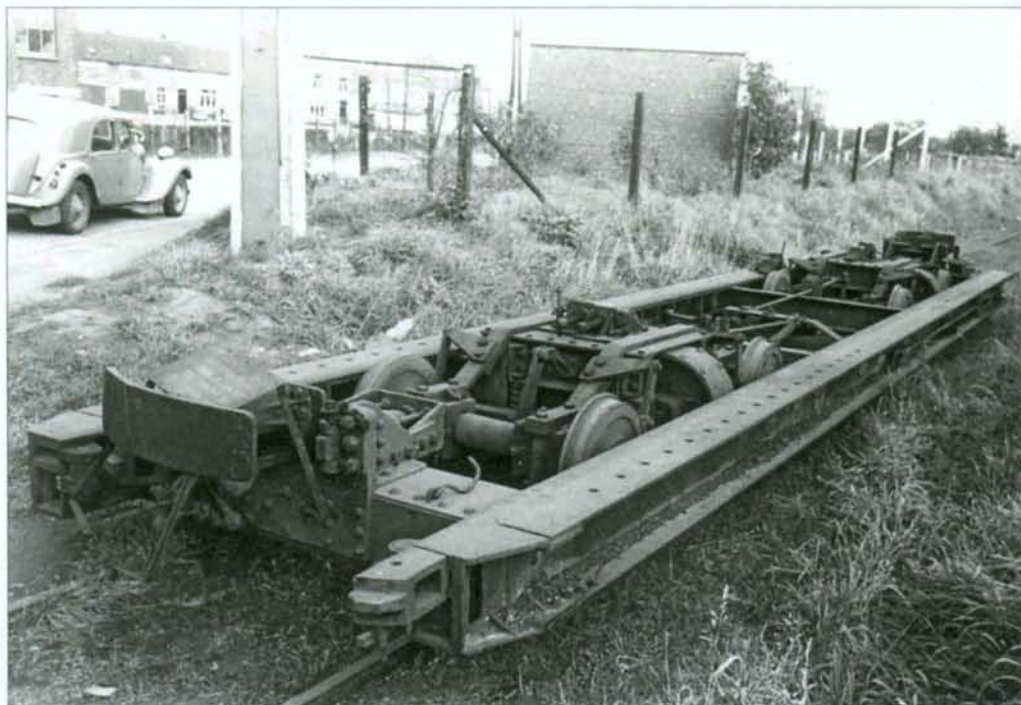
Pour desservir la sucrerie de Quévy, deux wagons porteurs étaient stationnés à Quévy. Ils avaient la particularité d'être équipé d'un tampon central vicinal. Nous ignorons son numéro. Voici un des wagons à Quévy en 1957.
