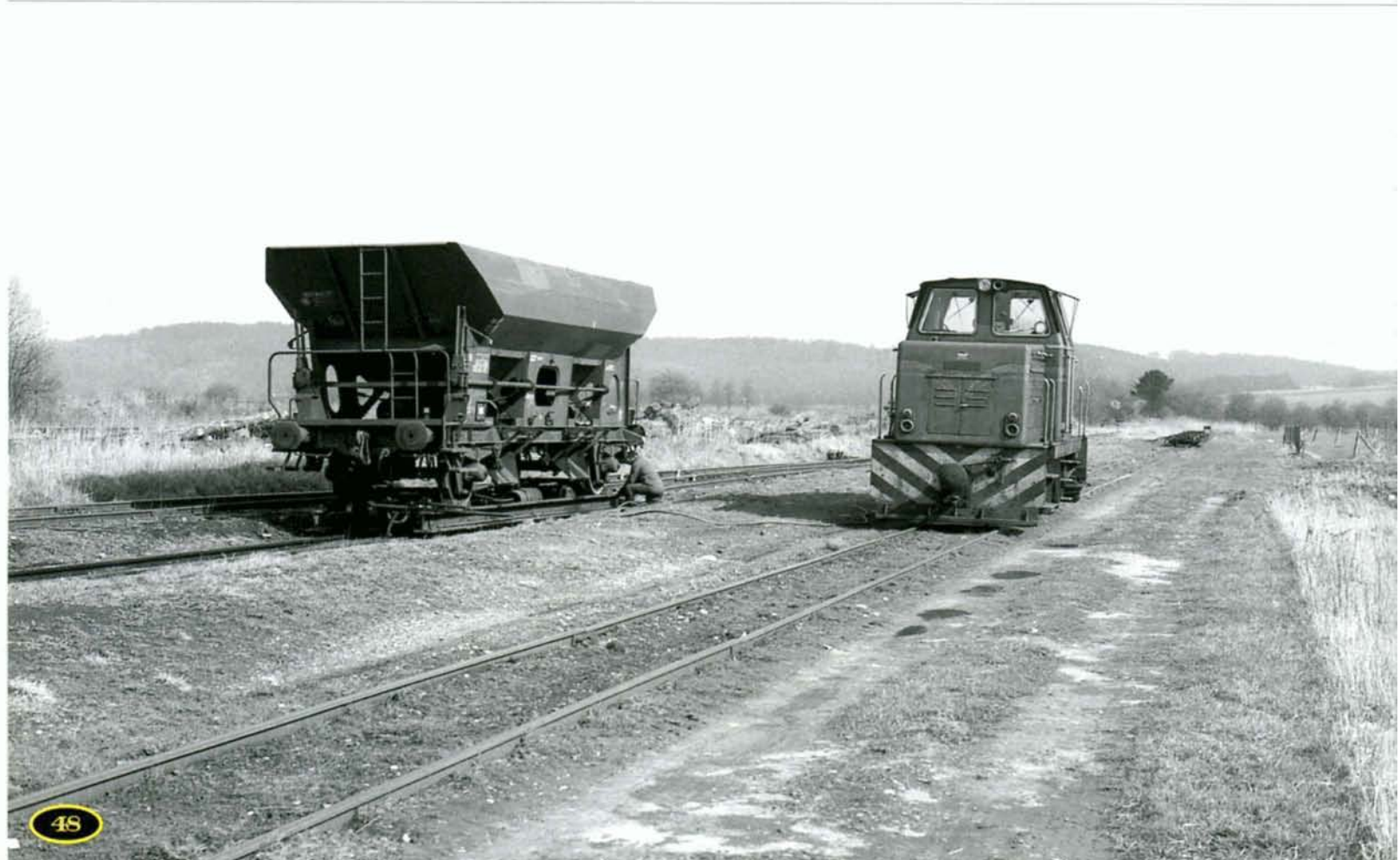
PHOTO 117-68 NB ↓ Après cette manoeuvre, la V15 se positionne parallèlement au wagon Fc. A l'aide d'un câble en cours de fixation, la V15 tirera le wagon hors du wagon porteur. Photo DIEU.
