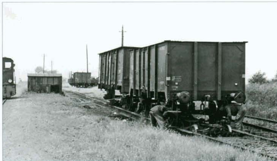
En gare de Warsage, mise sur wagons porteurs de deux tombereaux. La locomotive Diesel sert à tirer les wagons à voie normale sur les trucks porteurs à l'aide d'un câble. Les ouvriers placent les cales. Collection PFT.
