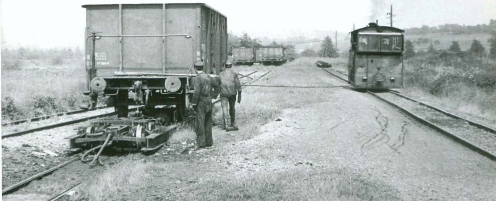
PHOTO 117-55 NB Le 4 mai 1965 en gare de Warsage, la locomotive 1075 (ex. SNCV) du Charbonnage d'Argenteau tire à l'aide d'un câble un tombereau à voie normale hors du wagon porteur. Cette opération se fait sur deux voies parallèles. La ligne 24 Visé - Montzen se situe à gauche de l'image à une centaine de mètres. Sergent J. BENSON, collection Maurice HENNEQUIN / PFT.
