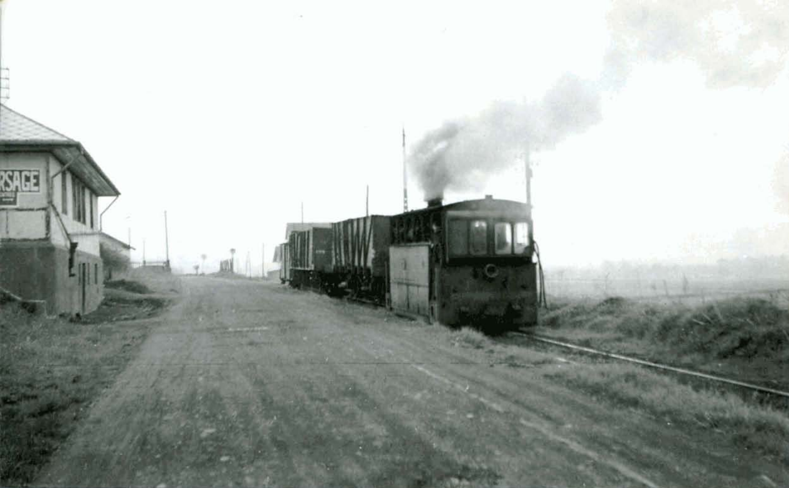
PHOTO 117-58 NB ↑ Le 20 avril 1957, un train remorqué par la locomotive 388 de la SNCV quitte Warsage. Le fourgon A.2435 est accouplé en queue. A gauche, la cabine de signalisation SNCB de Warsage. Collection M. STEINKAMP / PFT.
