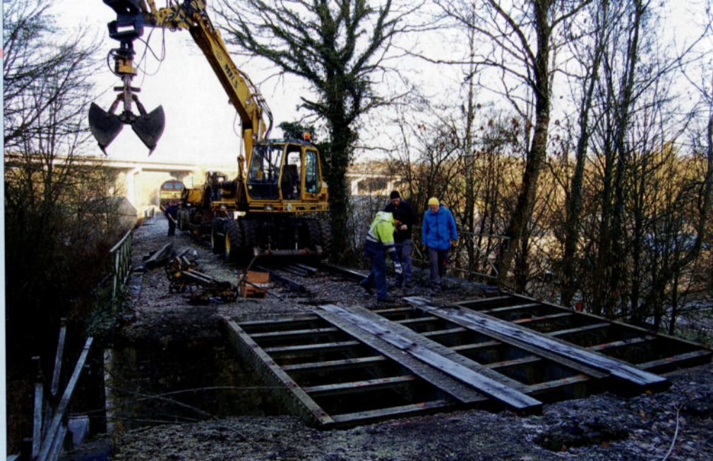
Le 2 février 2014, le tablier du pont de Senenne est préparé pour son départ en rénovation. Ci-dessous, transfert du tablier vers Spontin où il sera chargé sur un camion. PFT.
