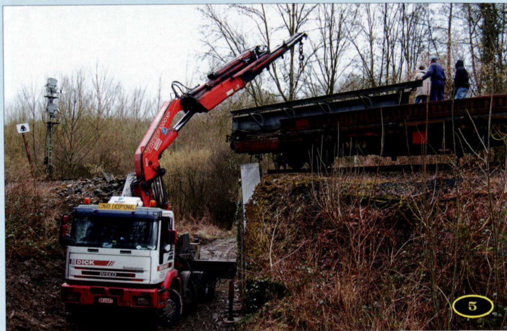
Le 3 février 2014, une grue place le tablier du pont de Spontin sur un wagon plat. Il sera chargé sur camion en gare de Spontin. PFT.
