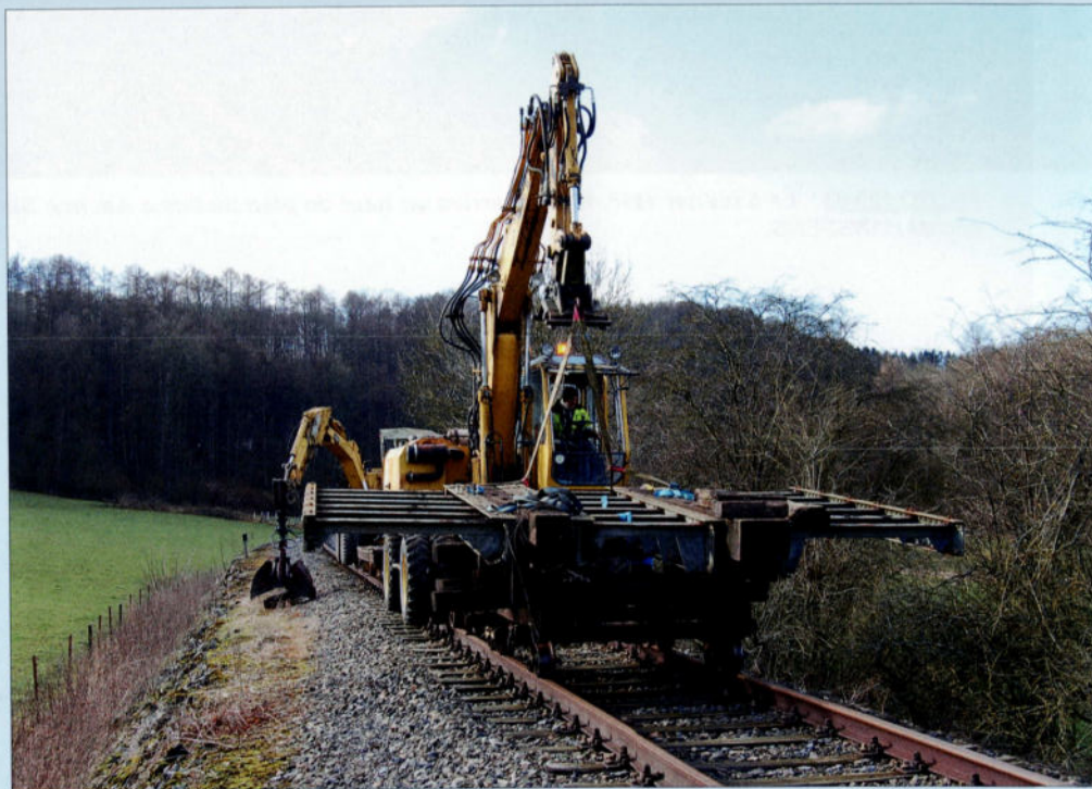
Le 3 février 2014, une grue place le tablier du pont de Spontin sur un wagon plat. Il sera chargé sur camion en gare de Spontin. PFT.
