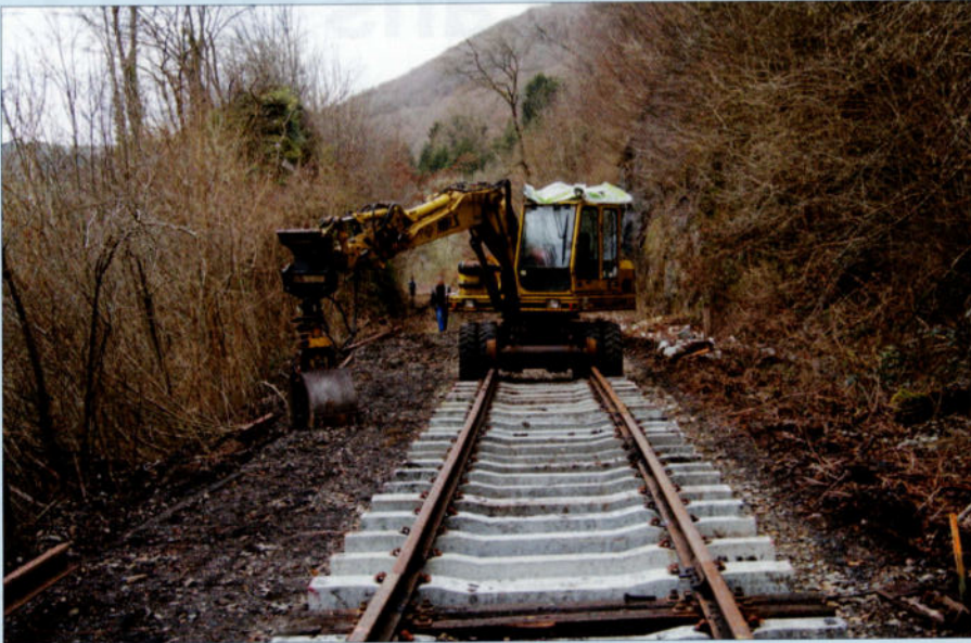
Les rails sont ensuite posés sur le lit de traverses, à l'aide de deux grues, dont une opère à l'avant de la voie (notre photo) et l'autre sur la voie déjà posée. PFT-CFB, 11 janvier 2015.
