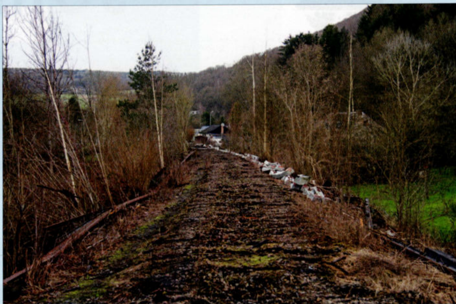
La première opération consiste à démonter l'ancienne voie, dont les traverses sont irrécupérables. Les nouvelles traverses sont posées sur le bas côté. Ici, une vue prise en direction de Bauche le 11 janvier 2015. PFT-CFB.
