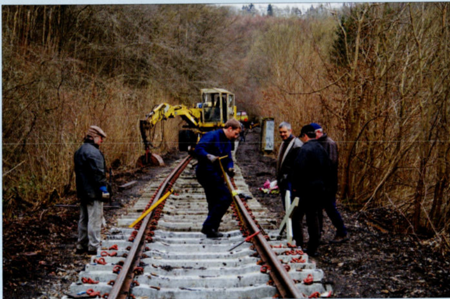
Après leur mise en place, les rails sont éclissés puis fixés aux traverses. Ce travail est entièrement réalisé à la main. PFT-CFB, 11 janvier 2015.
