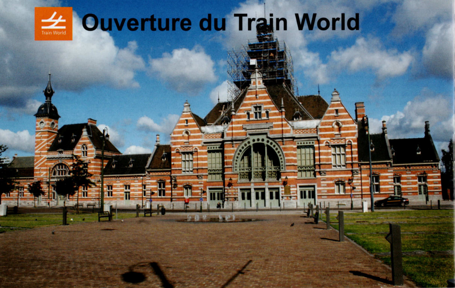
PHOTO 129-48 C'est dans la superbe gare de Schaerbeek que sont accueillis les visiteurs, dans la partie de droite datant de 1913. Le bâtiment de gauche, datant de 1887, accueille maintenant les voyageurs et le personnel de la gare. Jean-Luc VANDERHAEGEN 28 juillet 2015.
