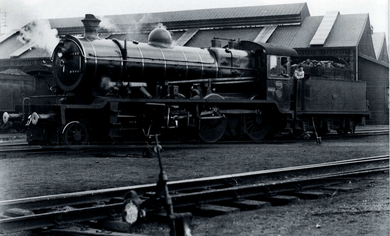
La nouvelle remise à 7 voies de Fragnée était établie entre la rue de Namur et le quai de Rome. Cette photo prise le 5 avril 1931 montre la type 8 bis n° 4607 du dépôt d'Herbesthal, photographiée dans son état d'origine devant la remise de Liège. Construite par Cockerill (n° 2969), elle fut livrée à l'Etat Belge le 22 juillet 1922 et mise en service à Liège. En octobre 1931, elle devint la type 7 n° 707 puis, le 1er janvier 1946, la 7.007. Evincée par la traction Diesel, elle sera définitivement éteinte le 11 mai 1960 au dépôt de Bruxelles-Midi. Le petit bâtiment en bois accolé à droite de la remise est la loge des laveurs. Collection Maurice HENNEQUIN / PFT.
