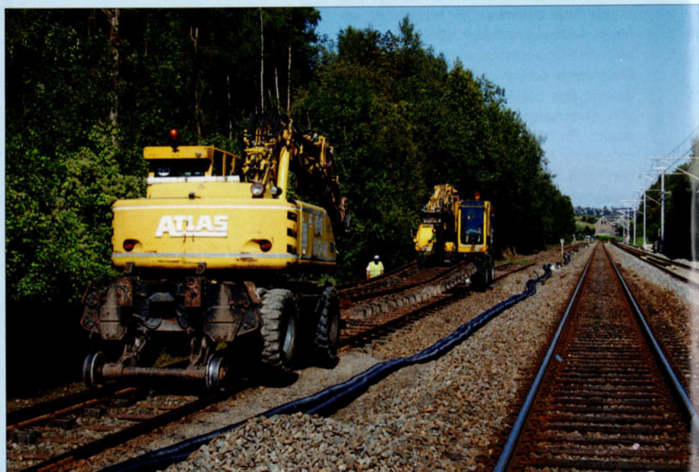
PHOTO 130-08 Le démontage de la ligne 128 entre Braibant et Ciney a été exécuté en 6 jours à l'aide de deux grues rail-route Atlas. La voie a été retirée par coupons de 18 m, lesquels ont été stockés en attendant leur remontage. PFT-CFB.
