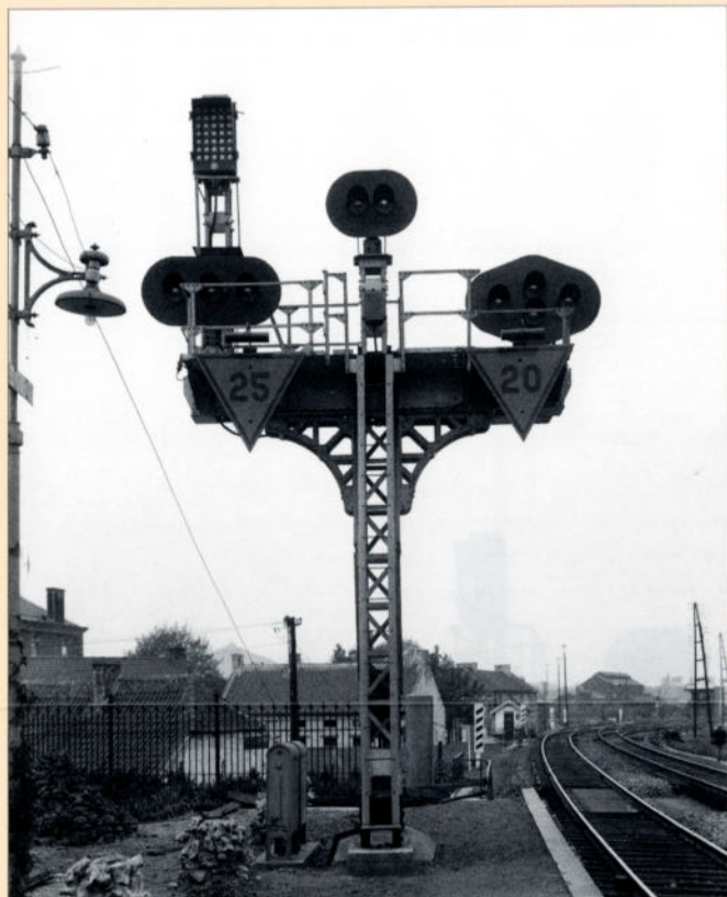
Ce chandelier était placé au bout du quai de la gare de Franière en direction de Charleroi. Au milieu se trouve le signal d'arrêt principal pour les trains continuant en voie directe. Le signal de gauche s'adressait aux trains entrant dans le faisceau de gauche. L'écran était surmonté d'un boîtier avec indication d'itinéraire. A droite, le signal était destiné aux mouvements bifurquant vers la droite. Nous remarquons également la présence de deux panneaux de vitesse : 25 km/h pour les trains bifurquant vers la gauche et 20 km/h pour les trains bifurquant vers la droite. Photo SNCB.
