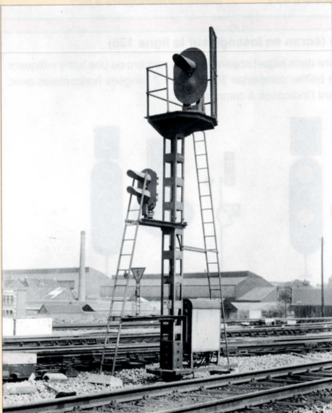
Un signal d'arrêt portant un écran de manoeuvres en gare de Schaarbeek. Nous remarquons que l'écran d'arrêt ne possède que le feu rouge. Le signal ne peut donc être ouvert que pour autoriser une manoeuvre. Fonds ACEC, collection Bois du Cazier.
