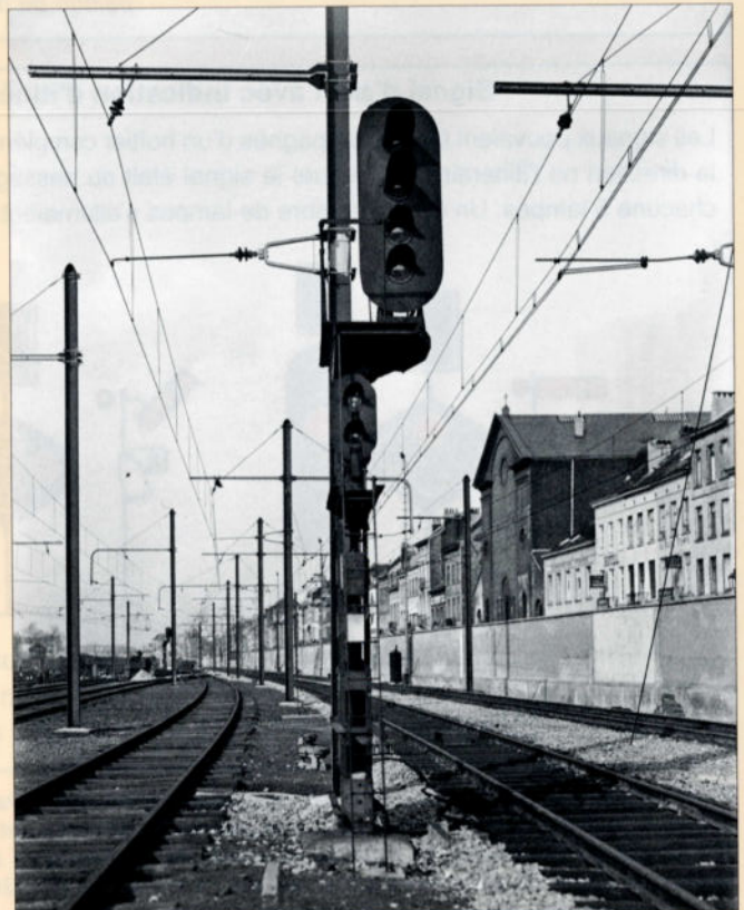
Ce signal d'arrêt implanté à la sortie de l'ancienne gare de Bruxelles-Nord en direction de Schaarbeek possède un écran de manoeuvres. Photo SNCB.
