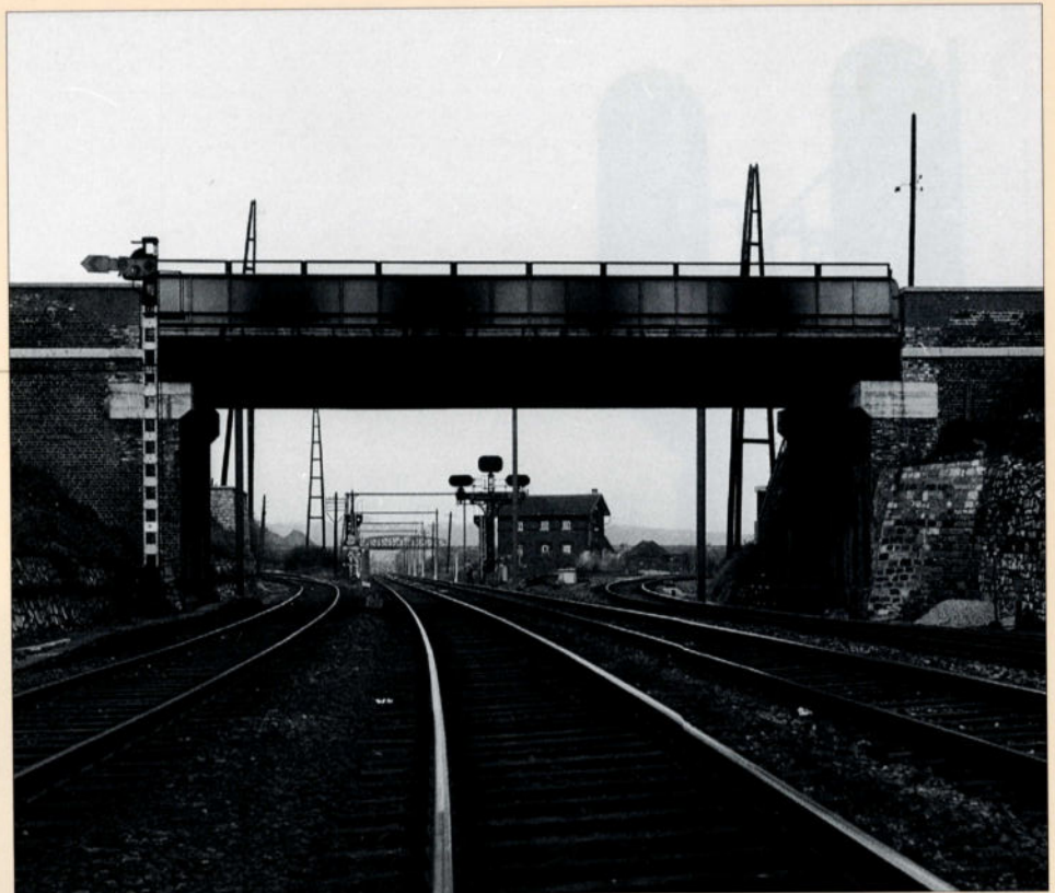
Cette photo a été réalisée à la sortie de la gare de Tamines, vue en direction de Namur. La ligne 130 était alors en cours d'électrification, les poteaux supports de caténaire étaient déjà visibles à l'horizon. Un chandelier lumineux commandait l'entrée de la gare pour les trains venant de Namur. A gauche de ce dernier, un signal lumineux du nouveau type était installé mais pas encore en service. La signalisation de 1932 sera supprimée lors de la mise en service de la traction électrique. La ligne bifurquant vers la gauche est la ligne 147 vers Fleurus; celle bifurquant vers la droite, la ligne 150 vers Aisemont, Ermeton et Dinant. Photo SNCB.
