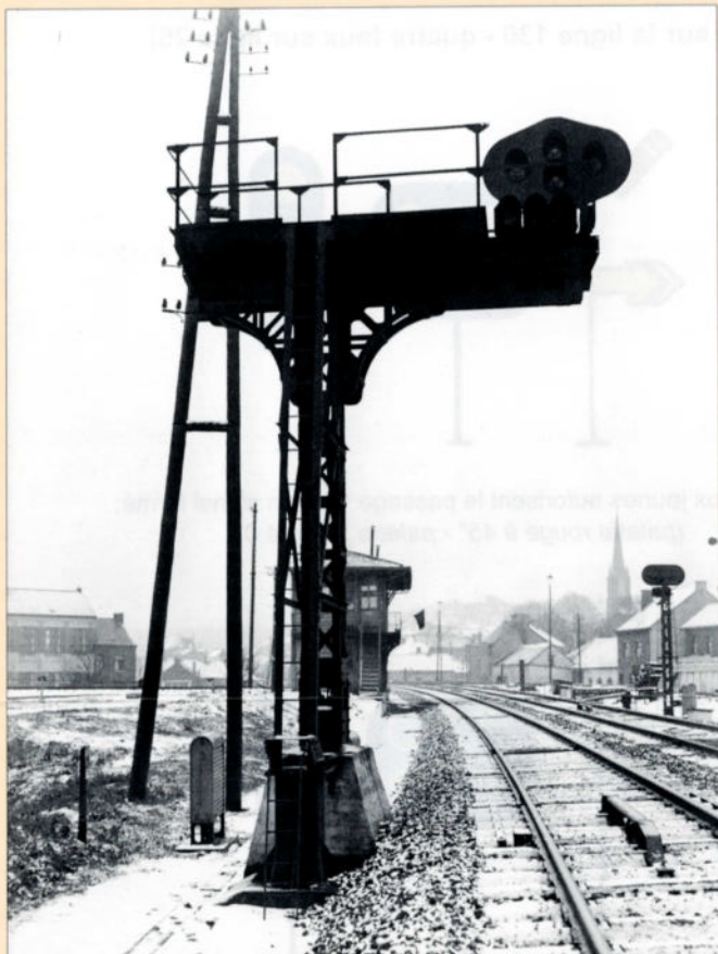
Le signal d'arrêt à quatre feux implanté à l'entrée de la gare de Couillet en venant de Charleroi-Sud. Photo SNCB.
