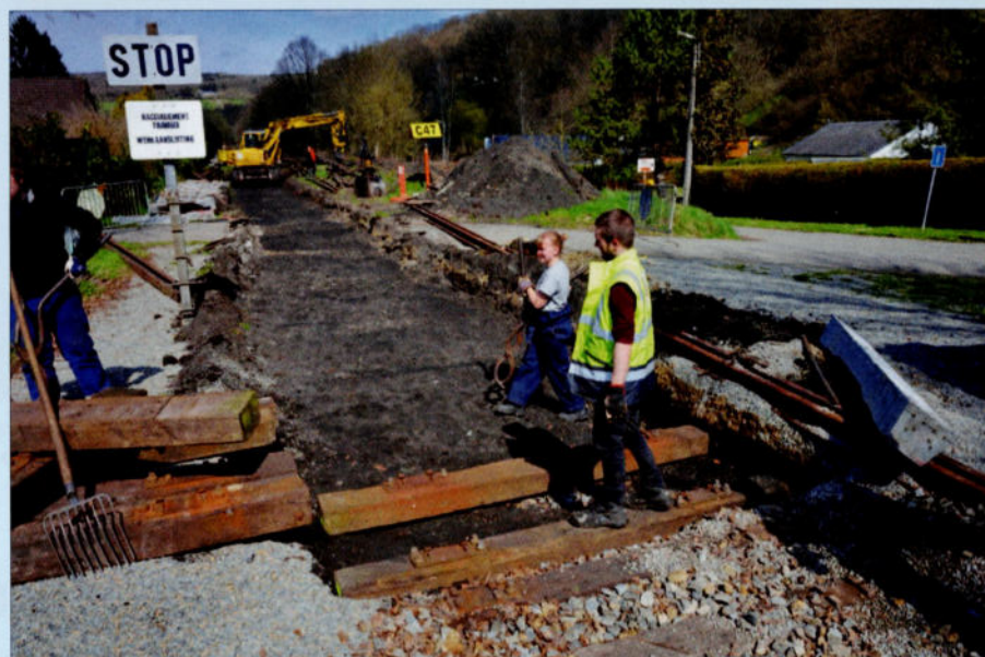
Les travaux de reconstruction de la voie en gare de Bauche. CFB-PFT.
