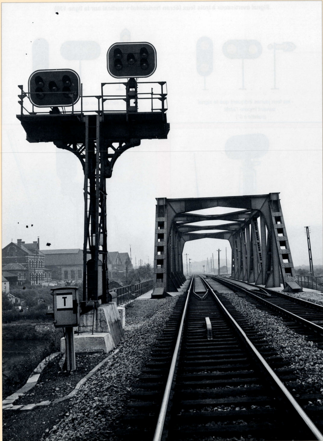
Un chandelier "lumineux" protégeait l'entrée de la gare de Tamines en venant de Charleroi, juste avant le pont franchissant la Sambre. Il était composé de signaux d'arrêt combinés à cinq feux chacun. L'écran de droite s'adressait aux trains poursuivant en voie principale, l'écran de gauche aux trains bifurquant dans les installations de la gare. A gauche se trouve la remise de Tamines. Photo SNCB.
