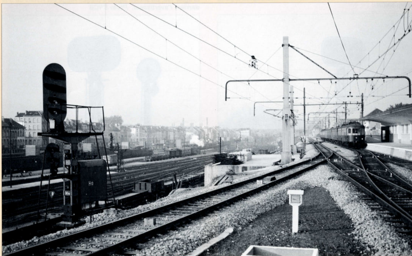
Lors des travaux de construction de la nouvelle gare de Bruxelles-Nord, la signalisation implantée fut celle de 1935. Les voies 10, 11 et 12 de la nouvelle gare étaient déjà en service et surélevées. Photo Bruno DEDONCKER, collection PFT.
