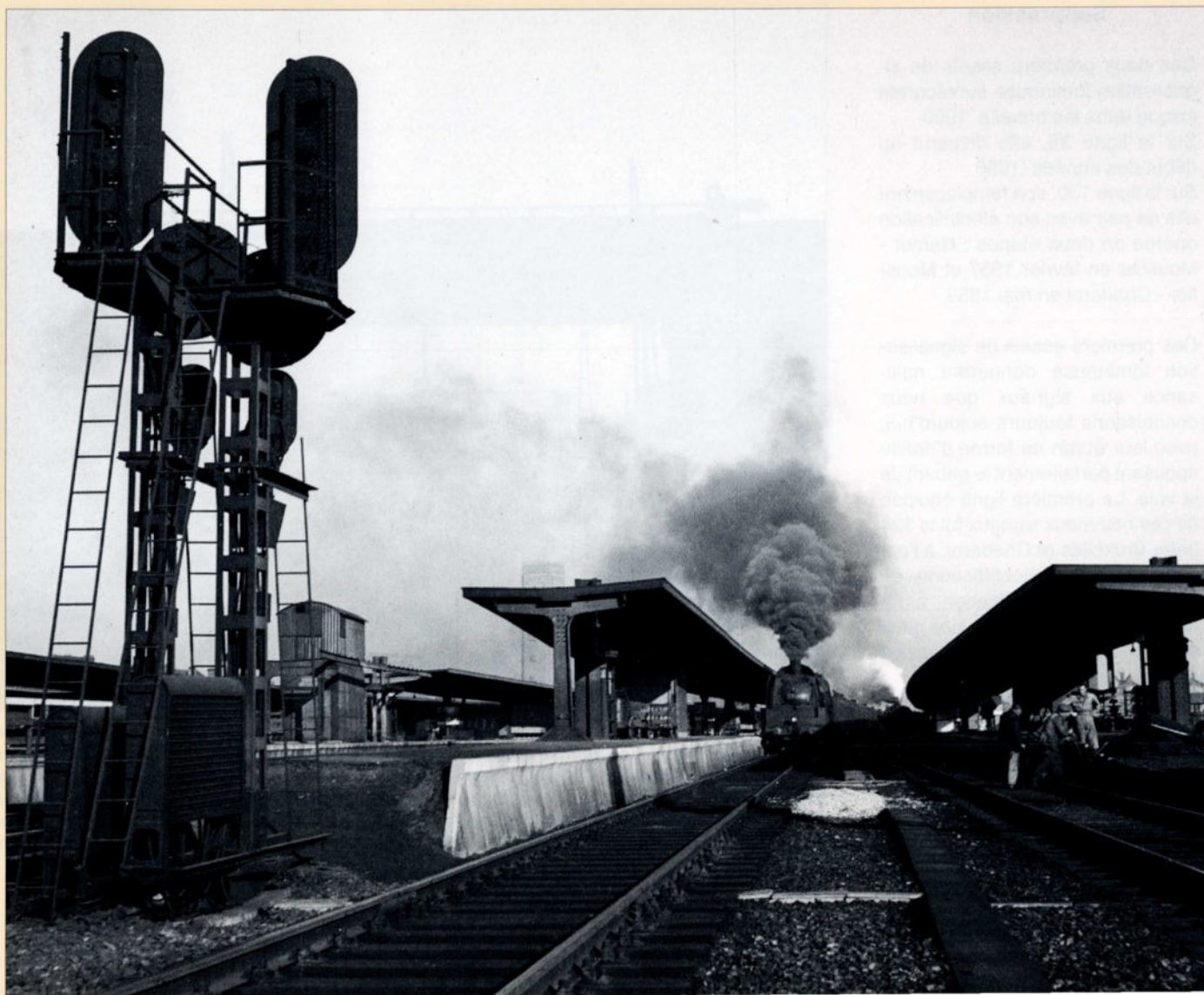
Une autre photo de la gare de Bruxelles-Midi dont les travaux n'étaient pas encore achevés. Seule la partie gauche de la nouvelle gare est en service. La partie droite, non visible, se trouve toujours en contrebas. Photo SNCB.
