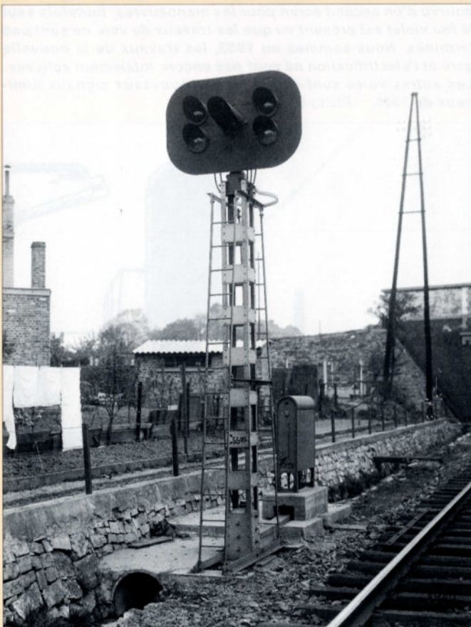
Un signal combiné à cinq feux implanté entre Charleroi-Sud et Couillet. Fonds ACEC, collection Bois du Cazier.
