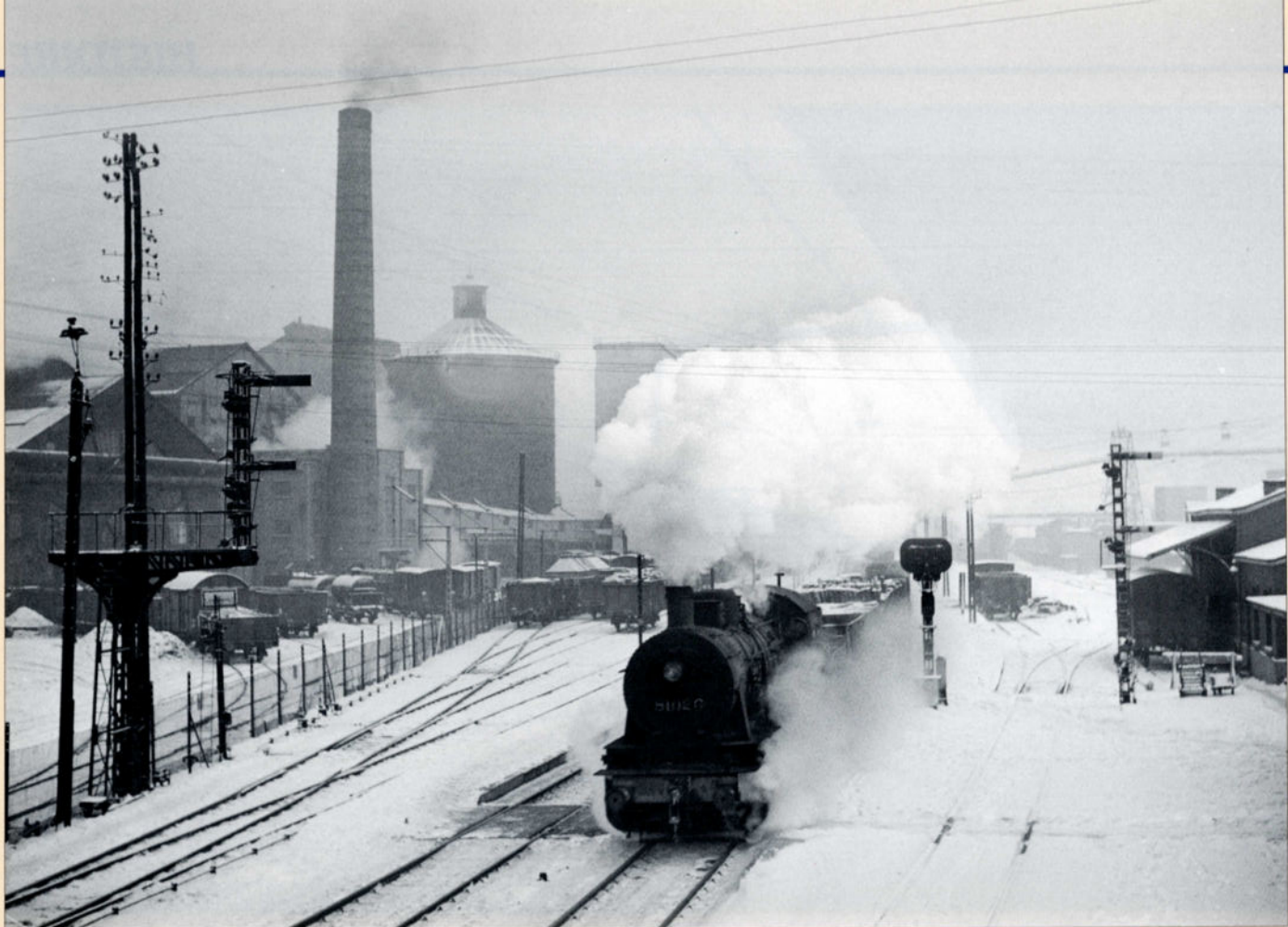
PHOTO 133-35 NB Le 14 février 1956, la signalisation lumineuse de 1932 était toujours présente sur la ligne 130. Passage en gare de Couillet d'un train de marchandises circulant en direction de Charleroi, tracté par la 81.026 de la remise de Luttre. Le train vient de franchir un signal d'arrêt à cinq feux, à écran carré. Photo Bruno DEDONCKER, collection PFT.
