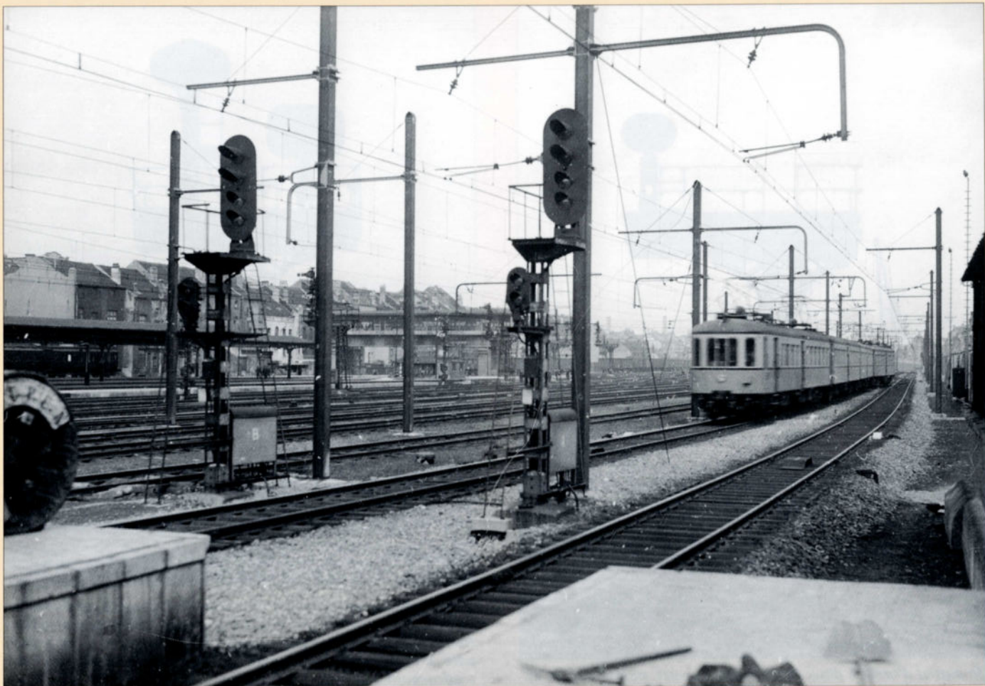
La ligne 25 Bruxelles-Nord - Antwerpen-Centraal fut équipée de la signalisation lumineuse lors de son électrification. Des signaux d'arrêt à quatre feux étaient implantés à l'extrémité des quais de Bruxelles-Nord. Un écran de manoeuvres complétait les signaux. Photo SNCB.
