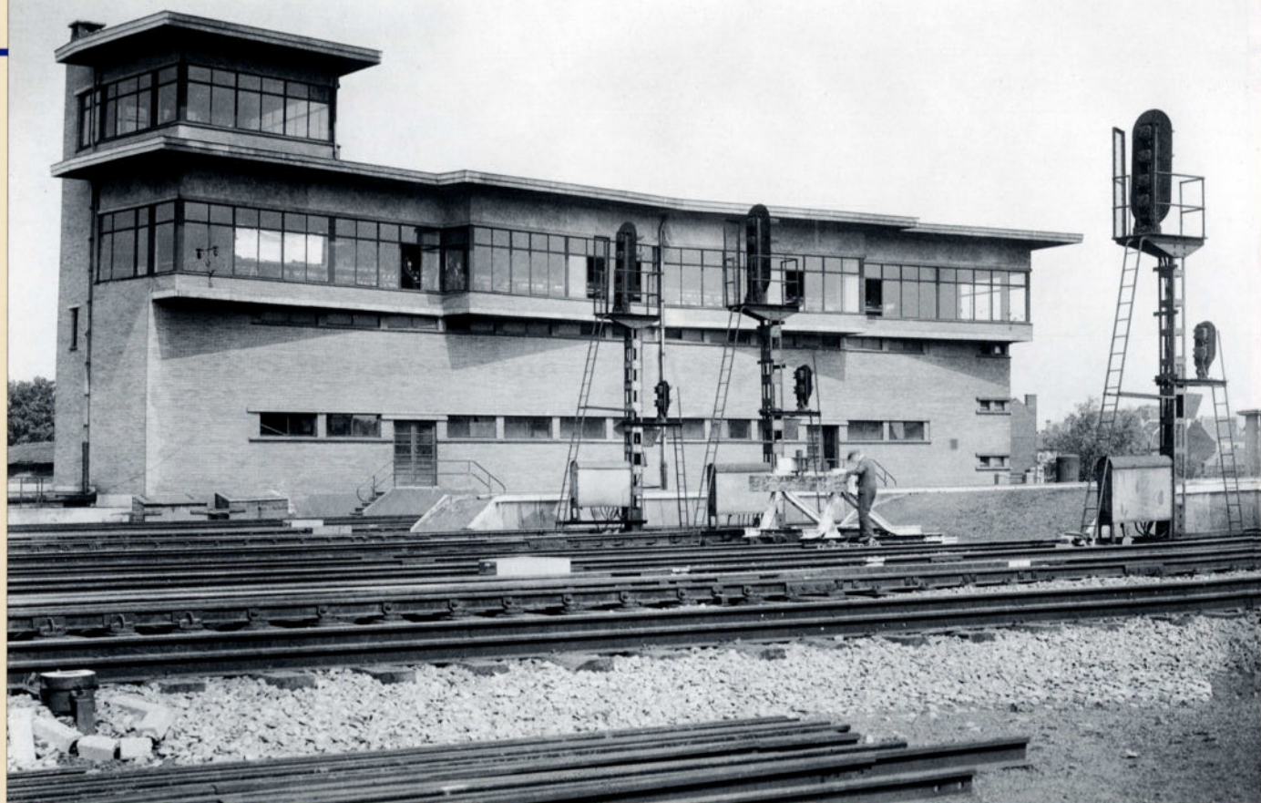
La gare de Bruxelles-Midi fut également pourvue de quelques signaux du type "Bruxelles-Anvers". Des signaux d'arrêt à quatre feux étaient implantés à l'extrémité des quais côté sud. Un écran de manoeuvres complétait les signaux. A l'arrière-plan, le block 2 équipé d'un bâti du type "Electrique ACEC". Fonds ACEC, collection Bois du Cazier.
