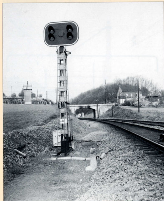
Ce signal était l'avertisseur du signal d'entrée de la gare de Jemeppe-sur-Sambre en venant de Namur. Il était implanté peu avant le point d'arrêt de Ham-Sur-Sambre visible après le pont. Photo SNCB.
