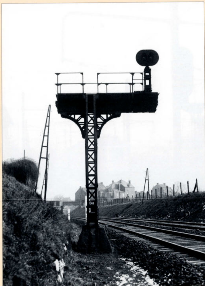
Un signal d'arrêt à deux feux, rouge ou vert, monté sur un ancien chandelier. Lieu non déterminé entre Charleroi et Namur. Photo SNCB.
