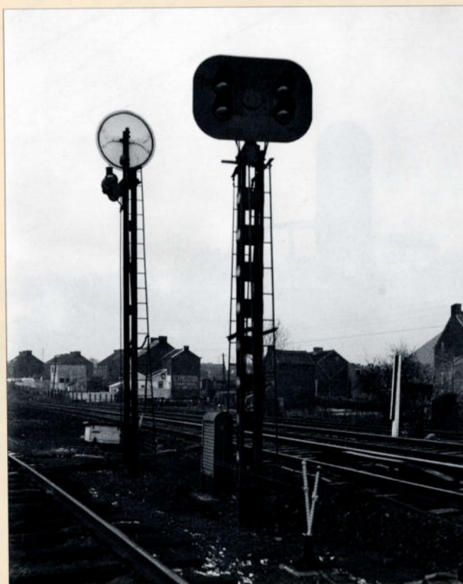
Encore un signal avertisseur à quatre feux implanté le long de la ligne 130. Un ancien signal à disque rouge est visible de dos derrière l'avertisseur. Photo SNCB.
