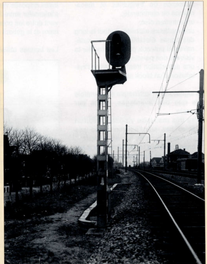
Sur la ligne 25, les écrans étaient placés verticalement, comme ici au bout des quais de la gare de Vilvoorde. Photo SNCB.
