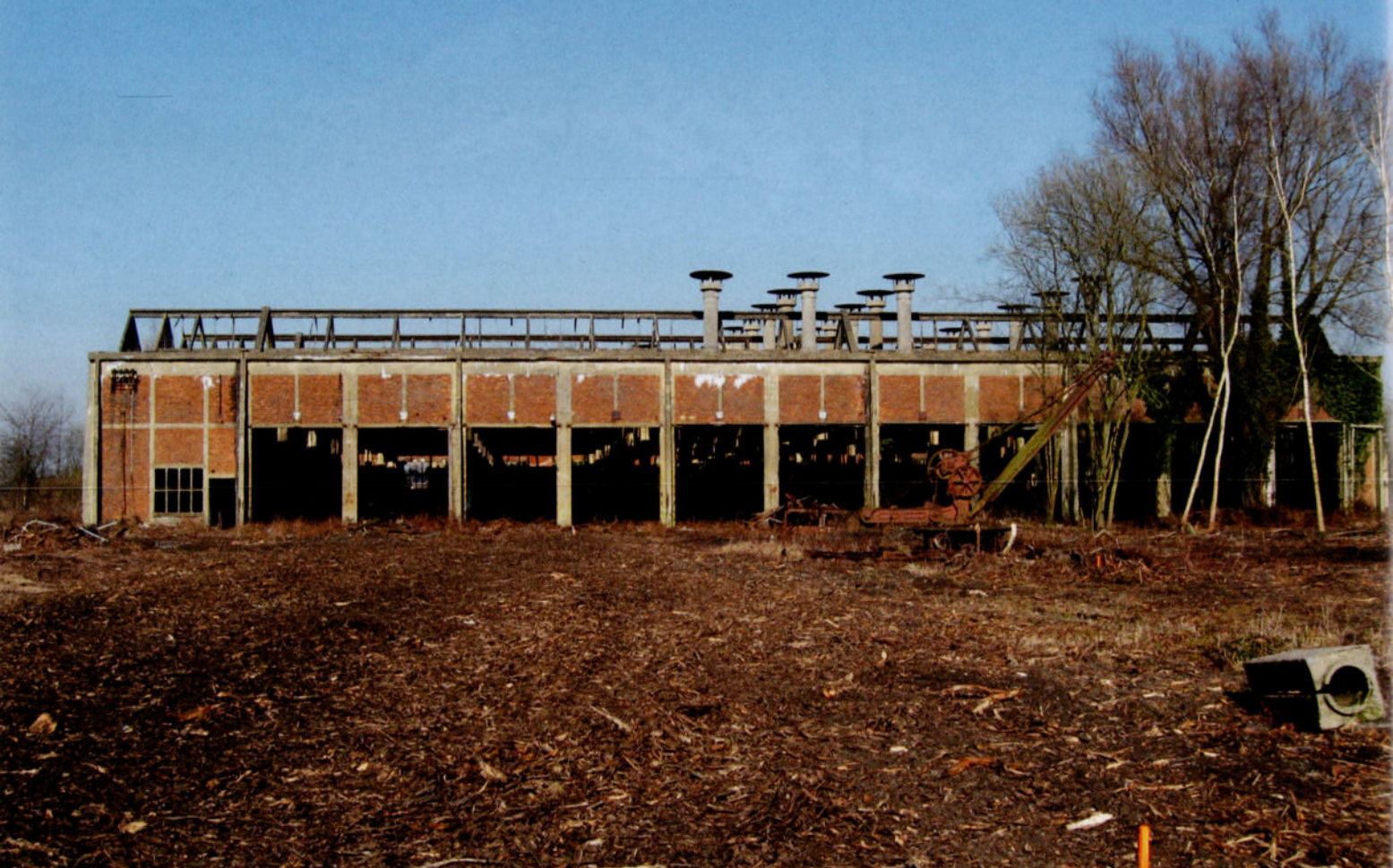
PHOTO 133-25 Le 17 mars 2016, les abords de la remise ont été nettoyés de la végétation qui avait envahi tout le site. Des immeubles à appartements et un parking vont bientôt occuper le site. A l'avant-plan, la grue manuelle. Baudouin DIEU.
