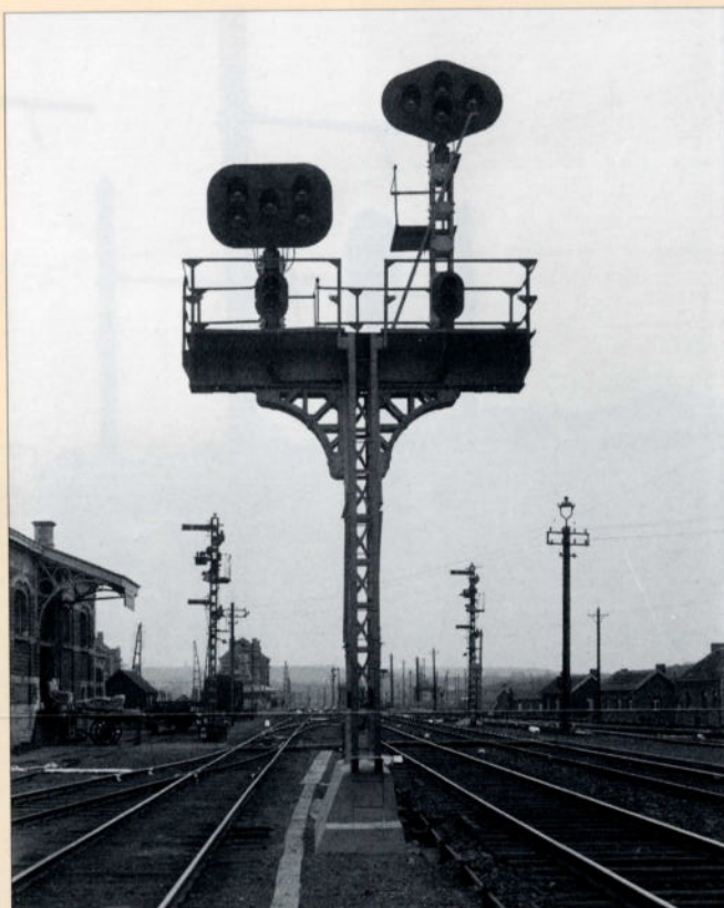
Ce chandelier était placé à Jemeppe-sur-Sambre en direction de Namur. L'écran de droite était un signal d'arrêt à quatre feux s'adressant aux trains poursuivant leur marche en ligne principale. L'écran de gauche était un signal d'arrêt à cinq feux s'adressant aux trains bifurquant vers la gauche. Les deux écrans étaient associés à des panneaux de manoeuvres. Fond ACEC, collection Bois du Cazier.
