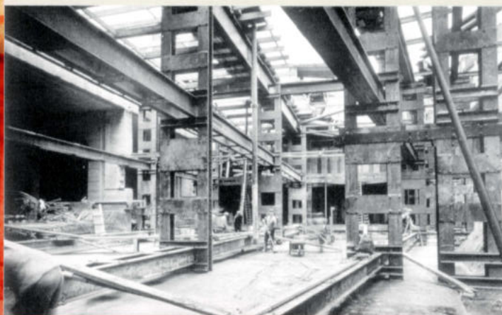
Pour construire l'impressionnante structure métallique du tunnel de la Jonction, on utilisait d'immenses poutres en acier. Photo: Sergysels, collection P. Pastiels
