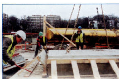
OPÉRATION DE DÉCOFFRAGE.
