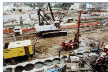
CÔTÉ COLLINE : EMPLACEMENT DES PIERS QUI FORMERONT L'ENCEINTE DU PARKING
