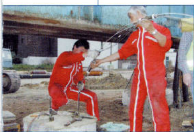
DESCENTE DE L'EXTENSOMÈTRE AMOVIBLE DANS LE PIEU.
