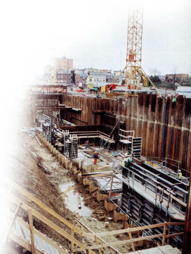
BASSIN D'ORAGE, CÔTÉ MEUSE.
