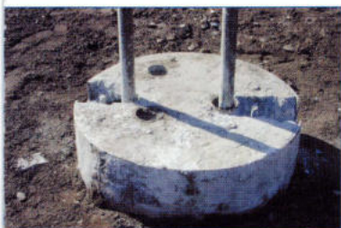
TÊTE DE PIEU MUNE DES TUBES EXTENSOMÉTRIQUES.
