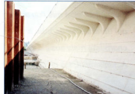
LE MUR DE SOUTÈNEMENT DU QUAI 1.
