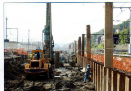
PALPLANCHES ET PIEUX POUR PRÉPARER LA CONSTRUCTION DU QUAI IV.
