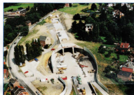
VAUX-SOUS-CHÈVREMONT: ENTRÉE DU TUNNEL DE SOUMAGNE.
