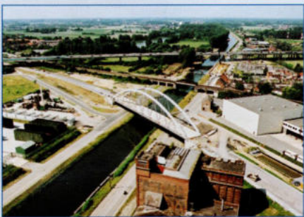
PONT SUR LE CANAL DE LOUVAIN.
