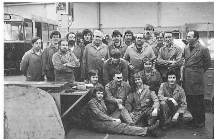
Centrale werkplaats Hoboken. plaatslagers.
