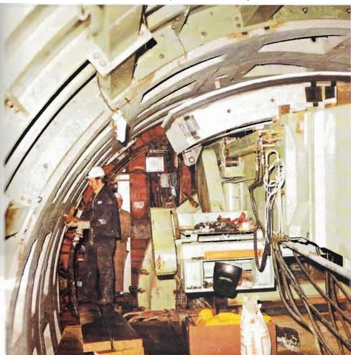
Schildmethode vak Turnhoutsebaan — Stenenbrug — april 1978: voorbereiding voor de injectie achter de tunnelbekleding (Foto G. Coolens).
