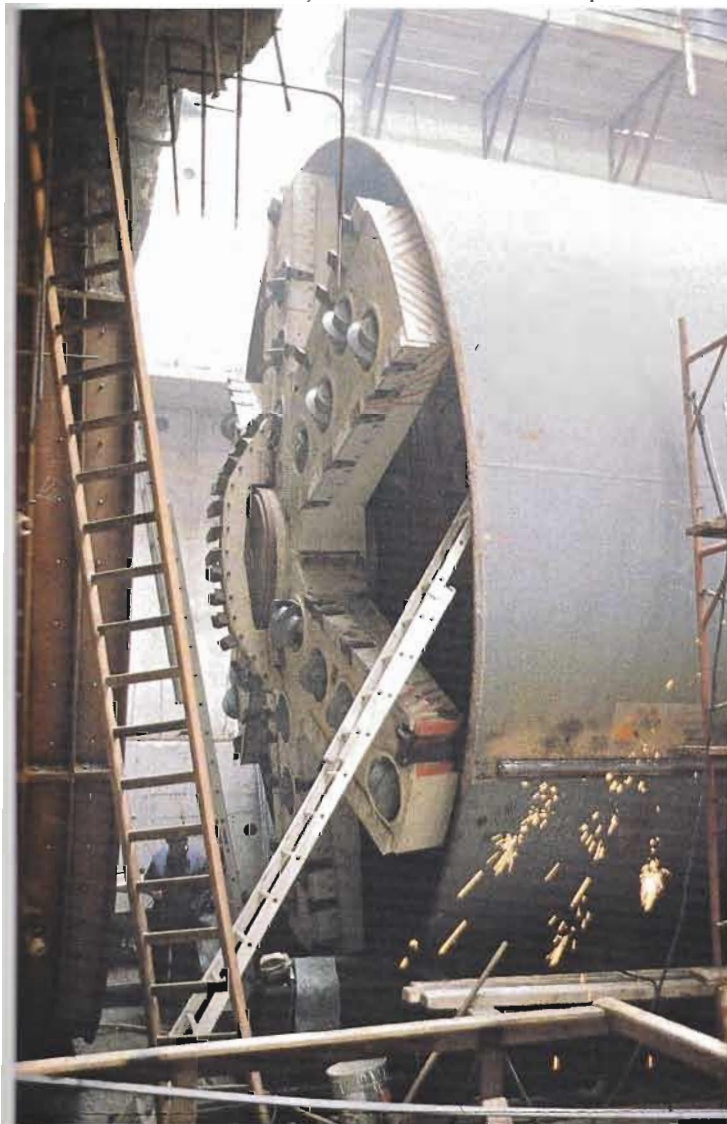
Linkeroever Station Frederik van Eeden — 10.9.1986: het schild bijna klaar voor een nieuwe opdracht.
