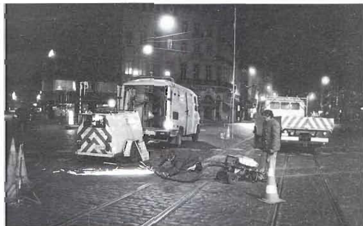
Mercedes-Schörling ladderwagen voor het monteren van de bovenleiding.
