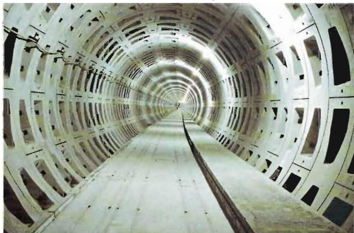
Schildtunnel klaar voor verdere afwerking.
