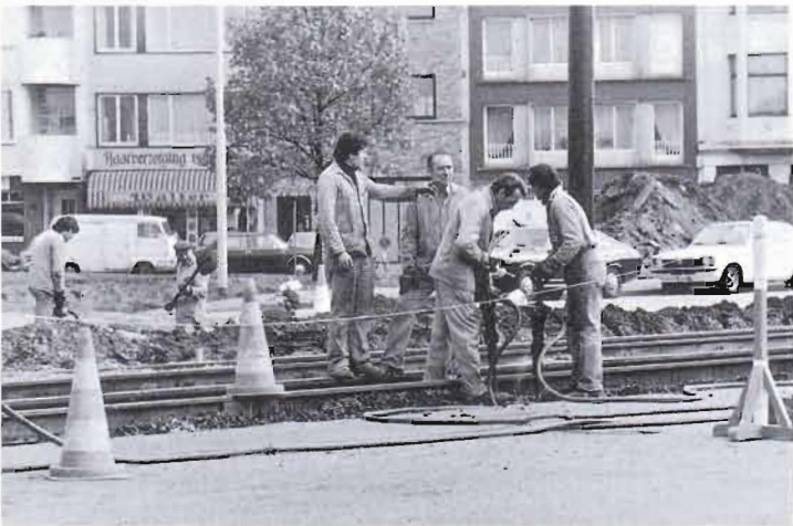
Aanleg van sporen.
