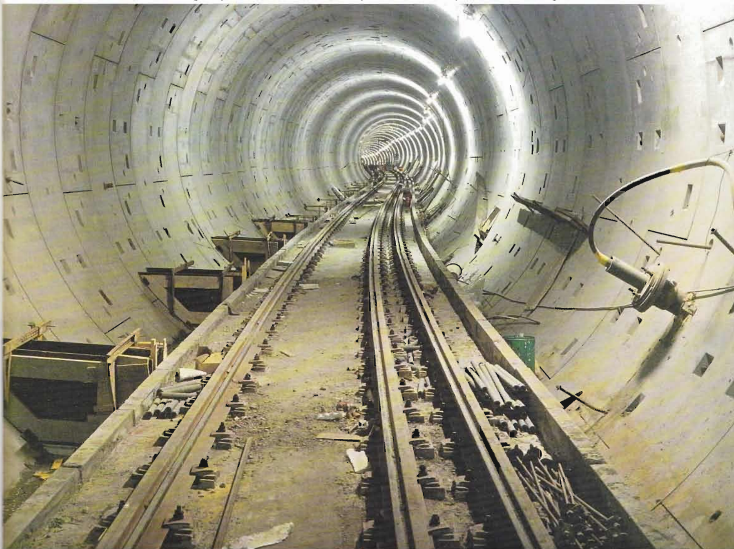
Linkeroeververbinding — april 1988: tunnel naar Groenplaats: wachtend op verdere afwerking
