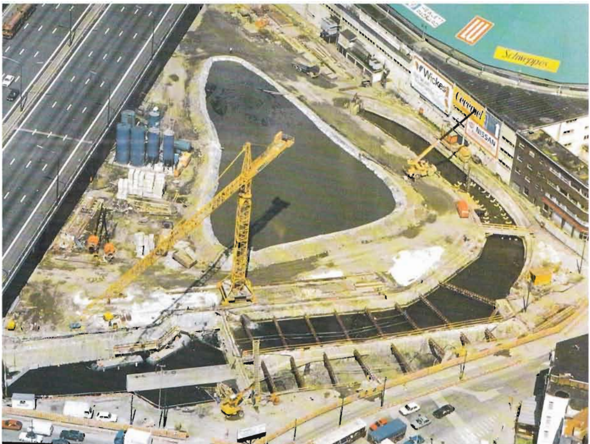
Station Sport en keerlus bij het Sportpaleis, mei 1986: voorbereiding voor het onder water storten van beton. © Van Hout.
