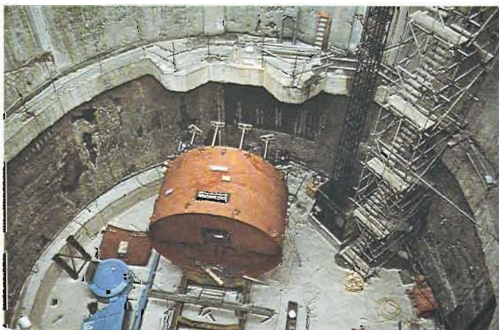
Het eerste schild in de vertrekschacht Stenenbrug — 19.12.1977.
