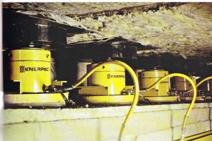
Hydraulische vijzels voor het compenseren van zettingen.
