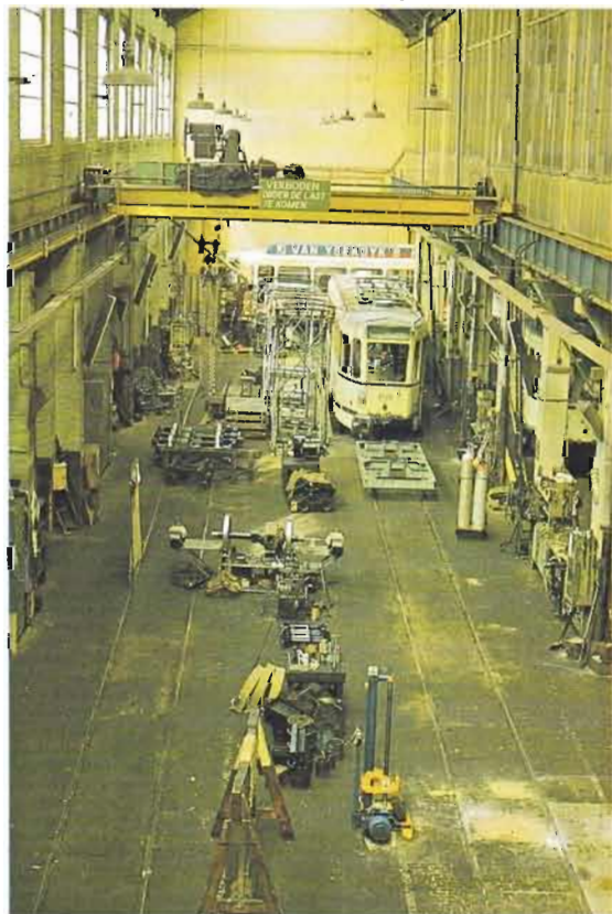
Beelden uit de oude centrale werkplaats.
