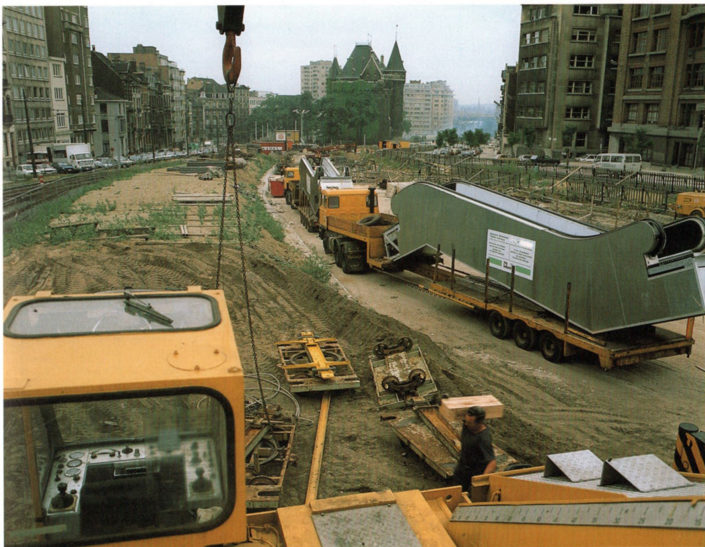
Fig. 16 / De roltrappen voor het station LOUIZA worden gelost
