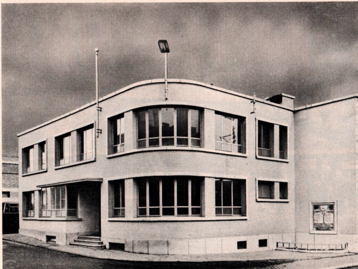
Fig. 6. — Gebouw voor het personeel van de beweging in de stelplaats te Luik-St-Gilles.
