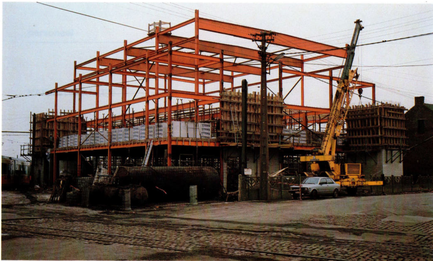
Ruwbouw van het „Beweging”gebouw te Jumet.
