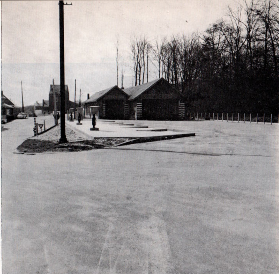
Parkeerplaats voor autobussen in de stelplaats te Lasne, met elektrische posten om de voorverwarming mogelijk te maken van de voertuigen in de winter.
