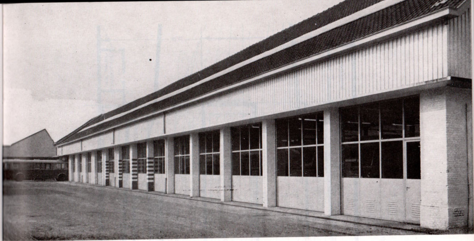
Voorgevel van de nieuwe werkplaatsen te Kuregem
