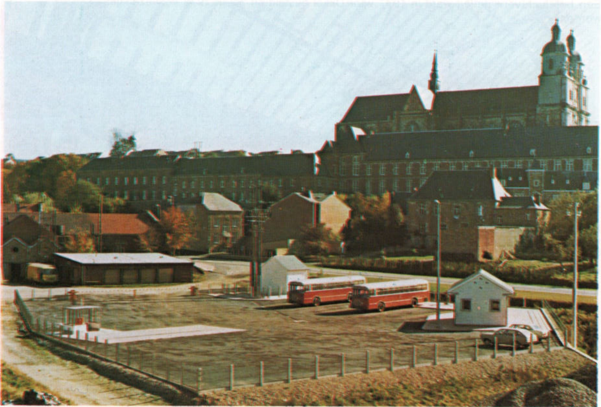
De stelplaats te Saint-Hubert na verbouwing.
