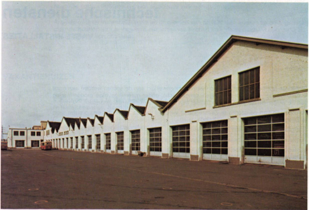
Werkplaatsen te Hasselt — Ingangspoorten voor autobussen.
