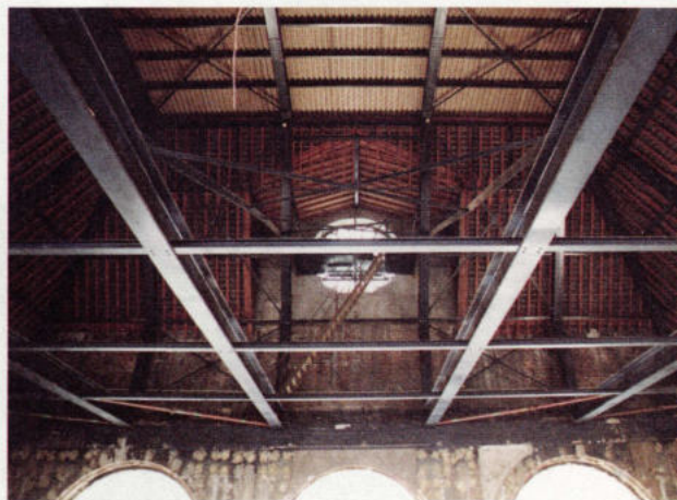
Travaux d'aménagement de l'entrée principale.
