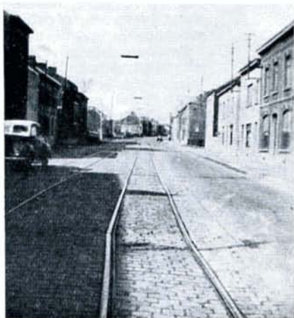
Cette photo a été prise à Chatelineau-Corbeau le 8 mars 1953, donc 5 mois après la réparation. Une nouvelle cassure s'est produite.
