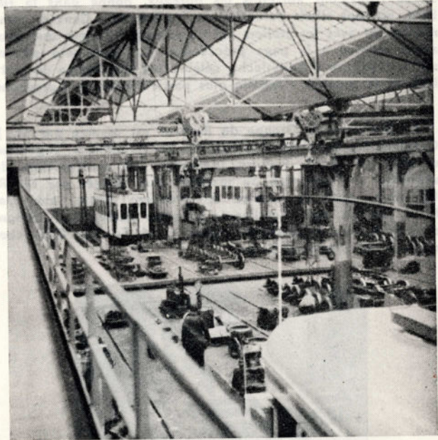
Une vue de la salle de levage, une passerelle permet de se rendre de la rue Eloy aux bureaux de la rue Bara.
