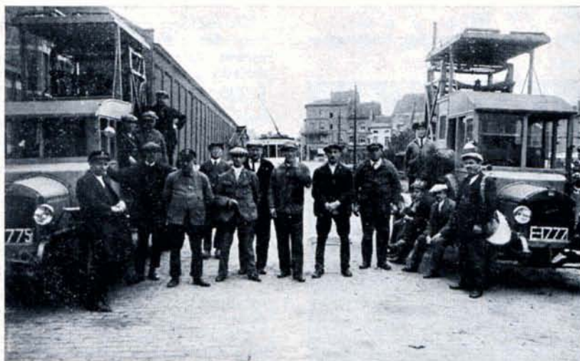
Voici un groupe d'ouvriers de la voie aérienne photographiés à la sous-station de la rue Vandermeiren à Bruxelles vers 1925. On remarque les premières voitures-échelles à moteur Bory-Pipe. Pour illustrer cet article, nous avons préféré utiliser des anciennes photos, car chacun connaît les voitures-échelles actuelles.
