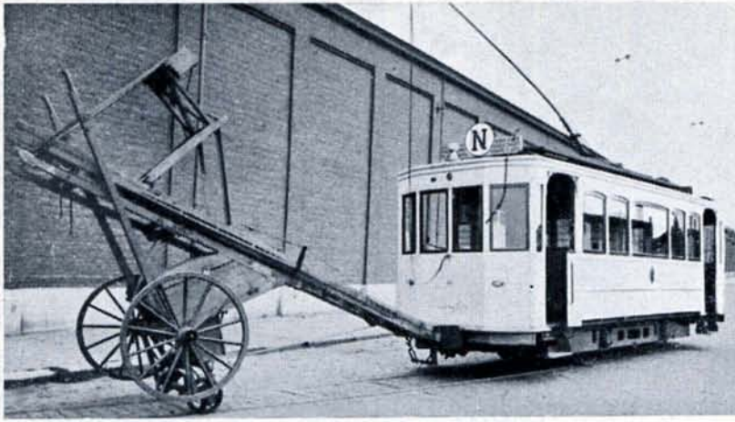
La charrette à bras à échelle coulissante pouvait être tractionnée par une voiture motrice. Il s'agit ici d'une motrice à deux essieux, sans portes, de la ligne « N » (Nord-Midi), service aujourd'hui supprimé, où furent essayés les prototypes des motrices à bogies appelées de ce fait « type N ».
