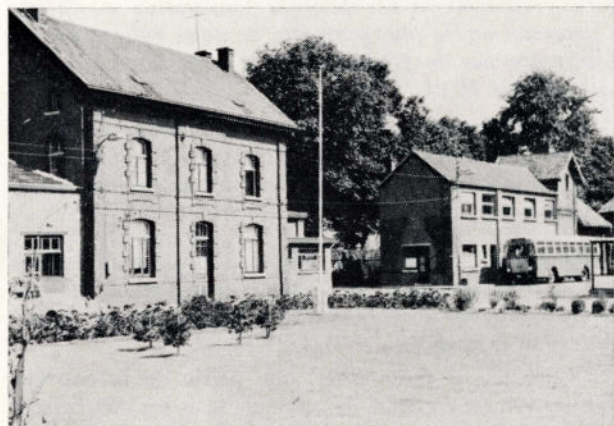
L'emplacement jadis réservé aux voies ferrées du dépôt vicinal a été transformé en une belle pelouse. Le garage proprement dit n'est pas visible sur la photo et se trouve plus à droite.
