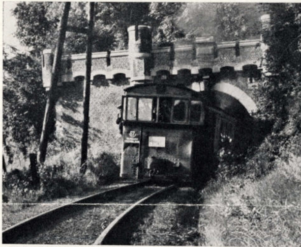
Sur le territoire de Dalhem, se trouve un des rares tunnels construits pour les Vicinaux, d'une longueur de 144 m. L'entrée et la sortie du tunnel ont reçu, en 1904, un décor médiéval; les lettres C.V. sont gravées dans la pierre de clé de voûte.
