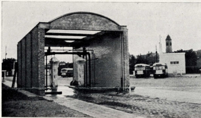
L'installation de lavage automatique.
