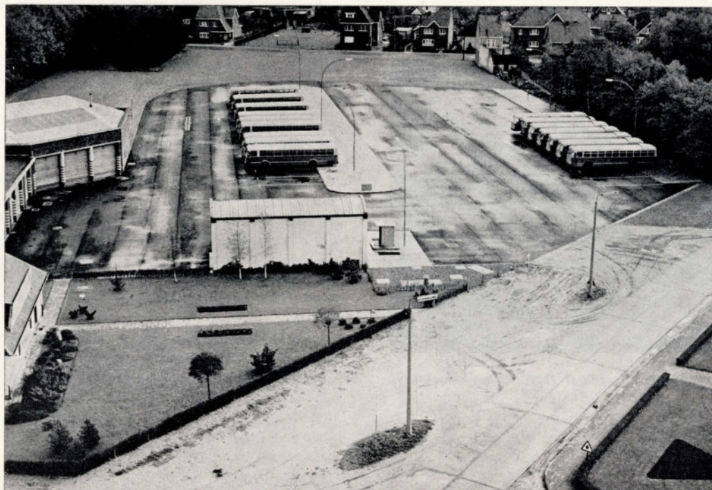
Parking pour autobus avec tunnel de lavage, à Genk.
