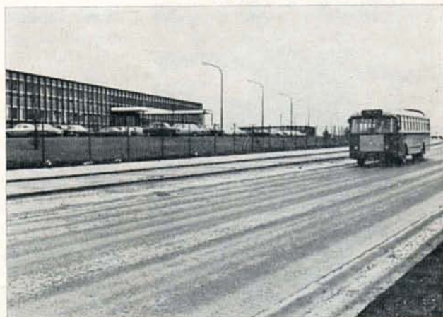
Dans ce parc industriel, la société Uniroyal Englebert a fait construire de vastes usines dont nous voyons ici l'entrée des bureaux. Remarquons la largeur de la voie de circulation qui comporte un trottoir pour piétons, une large bande de roulement pour vélos et vélos-moteurs et une chaussée pour le trafic automobile.
