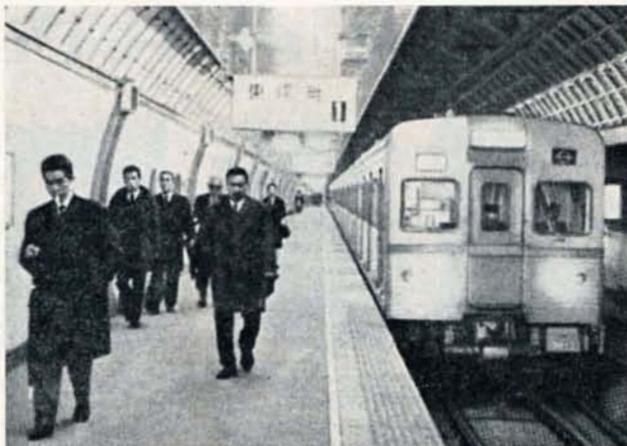
La Station Kiba de la ligne Tozai dans un tunnel de métro en forme de coquille. Les rails sont posés directement sur le béton, le courant est fourni par un fil aérien. Remarquez la longueur extraordinaire des quais.
