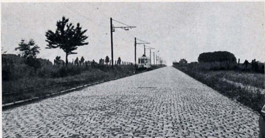
Le tram venant de Leerbeek arrive à proximité du croisement du boulevard Bracops, à Anderlecht.
