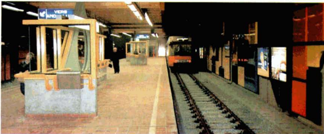
Vue intérieure de la station FONTAINE.
