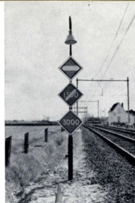
Waarschuwing voor de machinist: overschakelen van 1500 op 3000 Volt.
