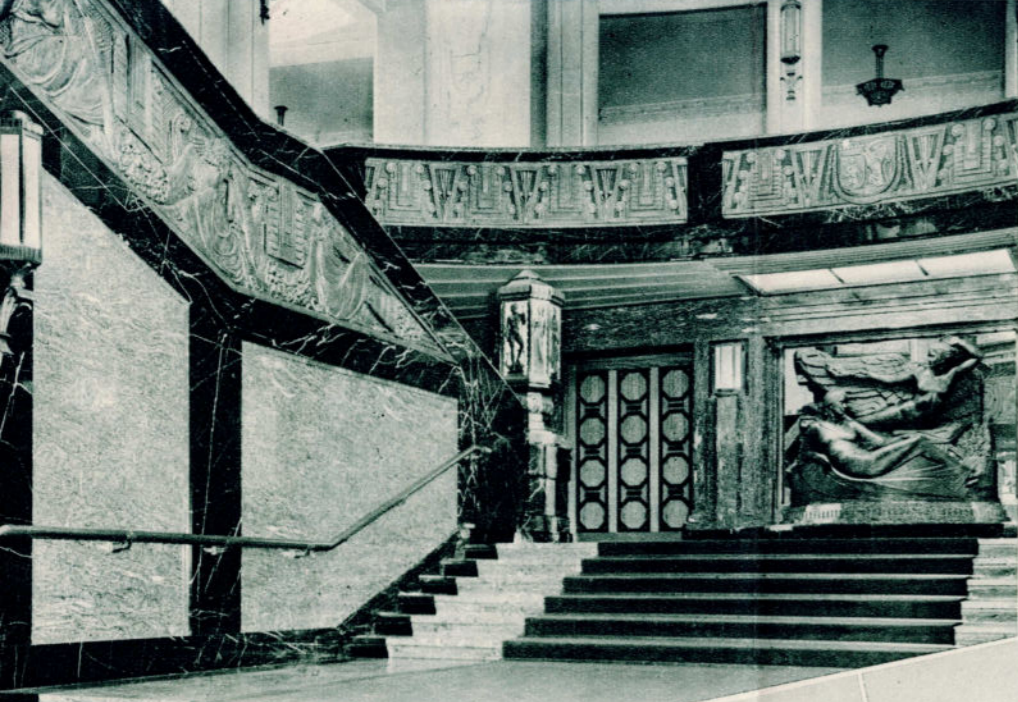
CHARLEROI. — HOTEL DE VILLE. STADHUIS. ESCALIER MONUMENTAL. MONUMENTALE TRAP. Ph. S. A. R.
