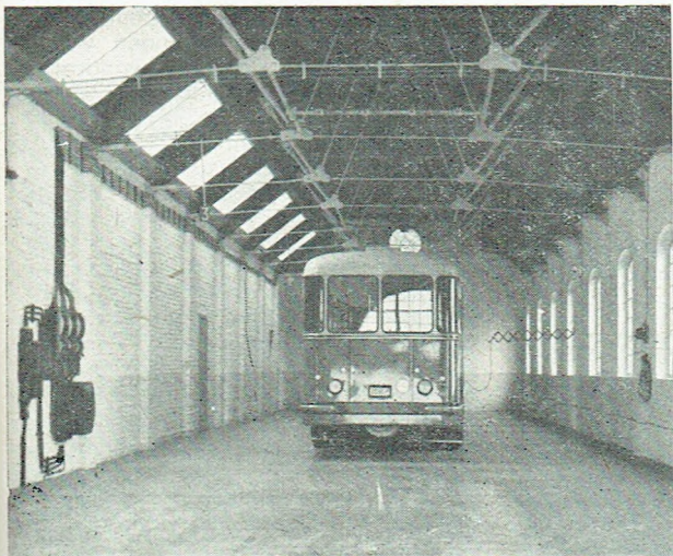
Zicht in de garage voor gyrobussen te Merelbeke — Op de achtergrond onderscheidt men een stroomcontact op uittrekbare arm. Wanneer de gyrobuss op de laadplaats gebracht wordt, aangeduid door nummer een, twee of drie, plaatst de geleider de steker in de zijwand van het rijtuig. Deze bewerking stelt eerst de gyrobuss in contact met de massa en vervolgens komen de stroomafnemers omhoog. Een schakelaar brengt dan de gyro in verbinding met de 220 V., voor het ingangzetten of voor het behouden op een maximum aantal toeren.
