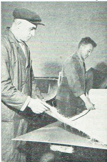
J. Renaert en M. Banken ontrollen de glaswol en meten de vereiste lengte af voor het vervaardigen van een kap.
