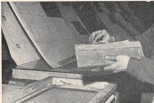
Het raam werd op de witte linnenband (richtingsfilm) gedrukt en de schilder brengt verf op de rubberband van het schraaptoestel.
