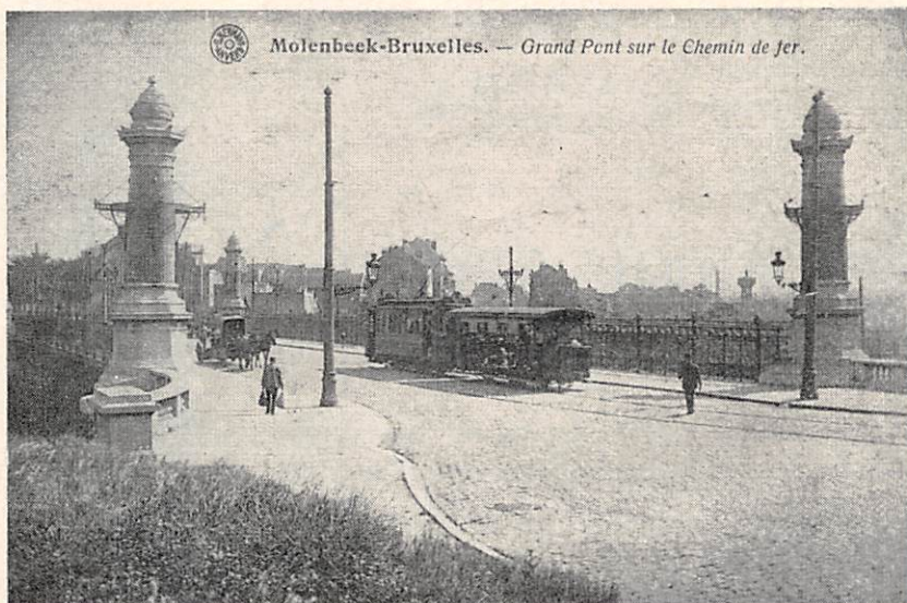
Een tramstel van de lijn Brussel - Wemmel rijdt over de spoorwegbrug te Molenbeek.
