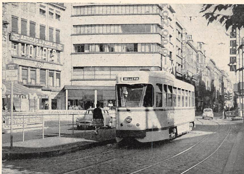
Op de place du Peuple, in het centrum van de stad, werd een ondergrondse doorgang aangelegd die toegang verleent tot de kaaien.
