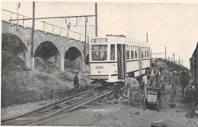
De eerste P.C.C. van de T.A.O. wordt op de sporen geplaatst in onze stelplaats van Zurenborg. (Foto Fr. Keutgens.)
