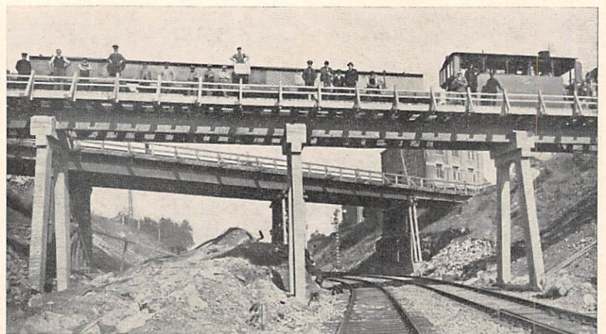
De wederopbouw van een brug te Bastenaken.
