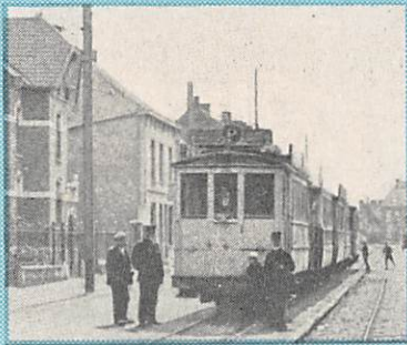
Foto genomen te Quaregnon, rue du Rivage, rond 1921, enkele tijd na het prijsgeven van de eenfazige stroom. Zie ons artikel blz. 3.
