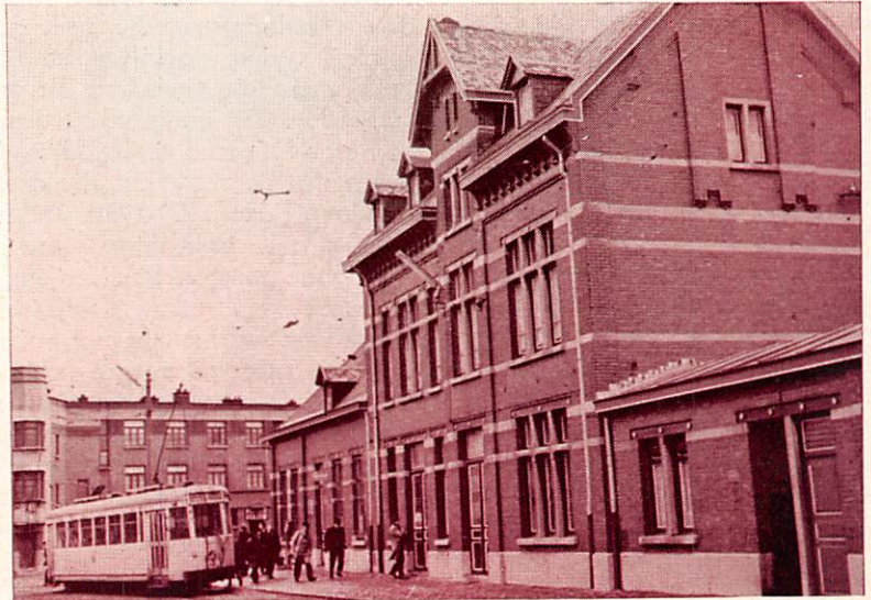
Een tram komende van Leerbeek voor de stelplaats.
