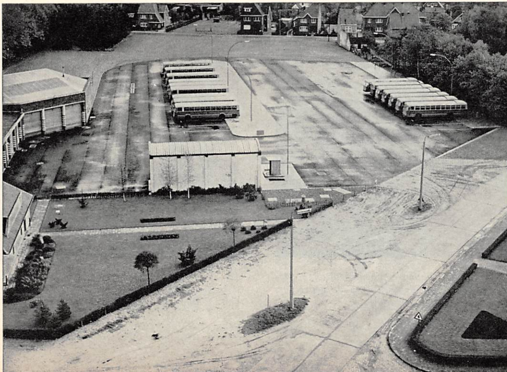
Parking voor autobussen met wastunnel te Genk.
