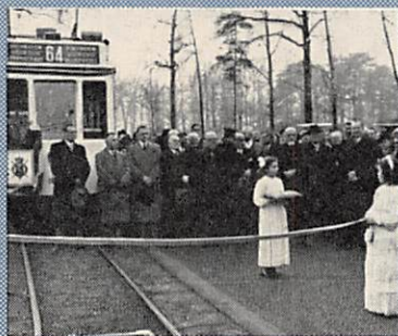
Op 23-12-1951 had de plechtige opening plaats van het elektrisch baanvak Brasschaat (Polygoon)-Wuustwezel. Op 25 mei 1968 reed de laatste elektrische tram van de Groep Antwerpen de stelplaats binnen. Zie blz. 18.
