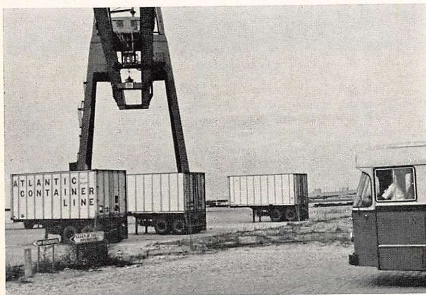
Sinds een drietal jaren maken de Noord-Amerikaanse reders veelvuldig gebruik van transcontainers voor het transatlantisch vervoer. Het zijn metalen kassen met een inhoudsvermogen van 25 à 30 t., die de drie volgende voordelen bieden: vlugheid, veiligheid en zuinigheid.
