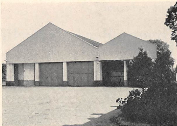
De garage van Eupen waarvan het bovenste gedeelte bedekt werd met aluminiumplaten.
