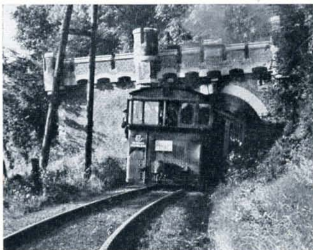
Op het grondgebied van Dalhem bevindt zich een van de zeldzame tunnels gebouwd door de Buurtspoorwegen. Hij heeft een lengte van 144 m., werd gebouwd in 1904 en de in- en uitgang doet denken aan een middeleeuwse versterking. In de sluitsteen zijn de letters C.V. gebeiteld.
