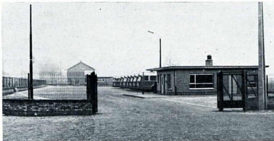
Het parkeerterrein voor autobussen met rechts vooraan het nieuw gebouw.
