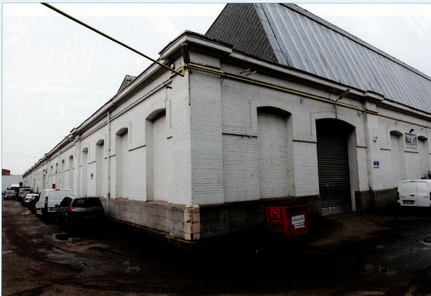
Een zicht op de achterzijde van de stelplaats. De draaischijf lag op de plaats waar de fotograaf staat. De ketel van de stoomloc type 28, die stoom leverde voor de verwarming van verschillende lokalen en diensten, bevond zich tegen de muur links (nr. 18 op de luchtfoto blz. 58-59). Jean-Luc VANDERHAEGEN, 6 februari 2014.
