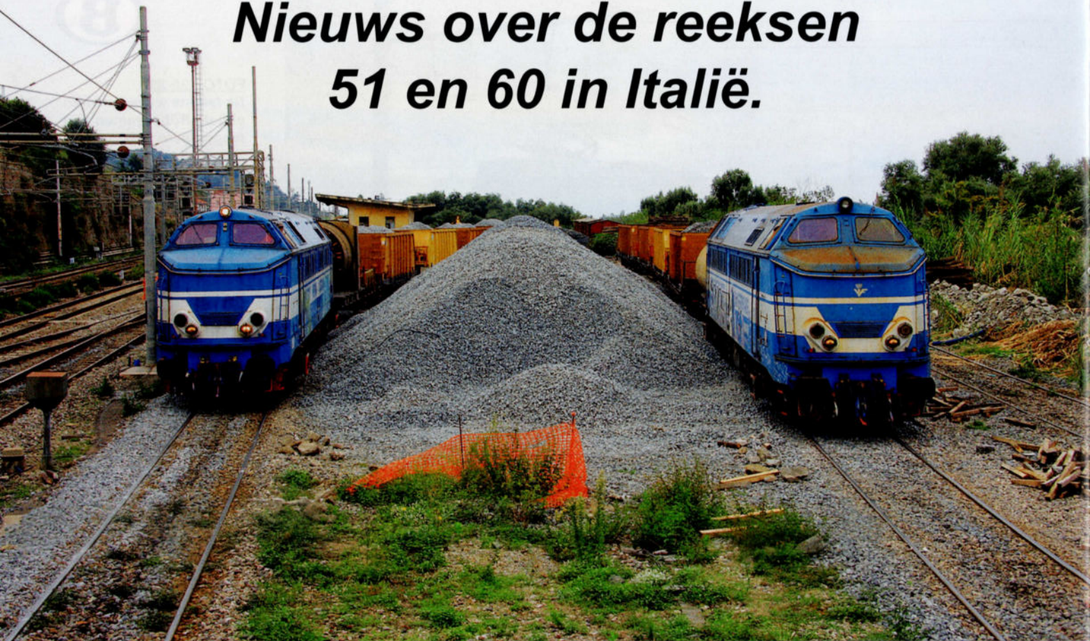
FOTO 125-30 Op een belangrijke werf voor de heraanleg van een lange spoortunnel (tunnel én sporen) te Palmi, op de lijn Paolo - Reggio Calabria, zijn niet minder dan vijf locomotieven reeks 51 van Ventura nodig en één locomotor van Duitse afkomst. In het station van Palmi worden twee ballasttreinen geladen, met aan kop links de 5170 en rechts de 5167. Pierre HERBIET.
