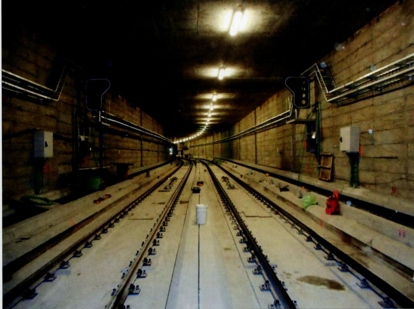
Deze beide foto's geven een goed beeld van de vooruitgang van de werkzaamheden. De technische uitrusting is grotendeels klaar, de signalisatie is reeds geplaatst. Enkel de bovenleiding ontbreekt nog. De lijn bestaat uit twee bloksecties en de refertesnelheid is 60 km/h. Wim DE RIDDER, 26 november 2014.
