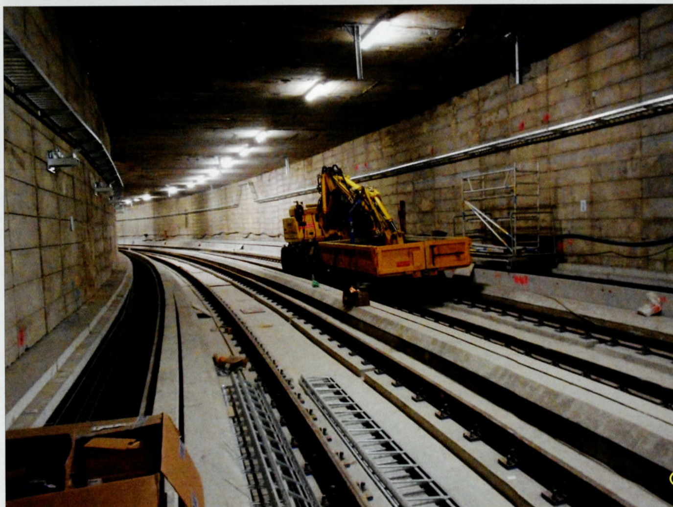
Deze beide foto's geven een goed beeld van de vooruitgang van de werkzaamheden. De technische uitrusting is grotendeels klaar, de signalisatie is reeds geplaatst. Enkel de bovenleiding ontbreekt nog. De lijn bestaat uit twee bloksecties en de refertesnelheid is 60 km/h. Wim DE RIDDER, 26 november 2014.
