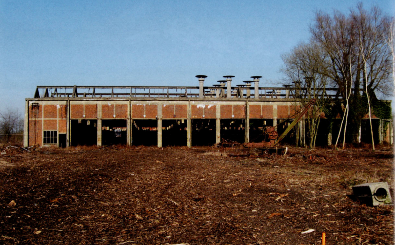
FOTO 133-25 Deze foto toont ons de situatie op 17 maart 2016. Het kreupelhout, dat de hele site overwoekerde, werd opgeruimd. Weldra komen hier flatgebouwen en een parking. Vooraan kan je de handbediende kraan waarnemen. Baudouin DIEU.
