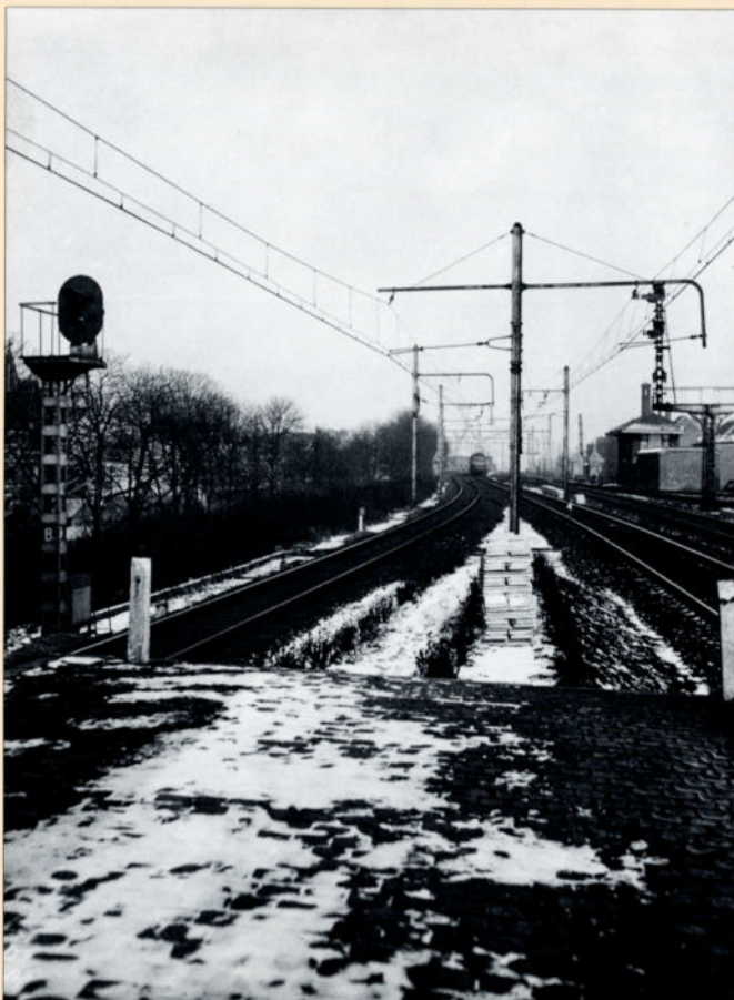
Een stopsein met twee lampen (rood en groen) in Vilvoorde, richting Antwerpen. De rechts zichtbare lijn 27, die naast de lijn 25 ligt, wordt nog met mechanische seinen beveiligd. Foto NMBS.
