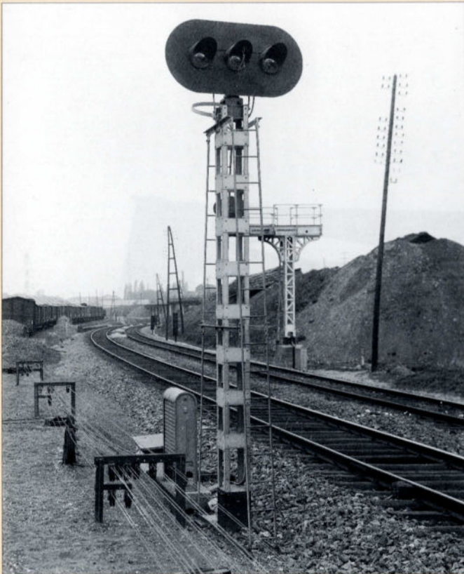
Een verwittigungssein met drie lampen aan de uitrit van Couillet richting Charleroi-Sud.
