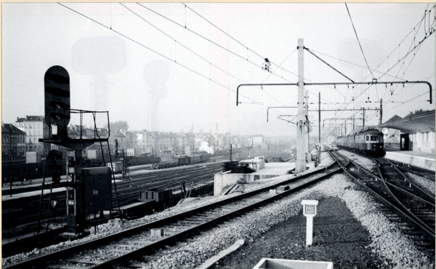
Tijdens de bouw van het nieuwe station Brussel-Noord werden lichtseinen van het type uit 1935 geplaatst. In 1950 komt een motorstel uit 1935 aan in het station. De verhoogde sporen 10, 11 en 12 van het nieuwe station waren al in dienst. Foto Bruno DEDONCKER, verzameling TSP.
