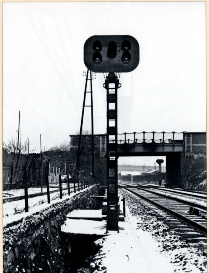
Een gecombineerd sein met vijf lampen tussen Couillet en Charleroi-Sud. Foto NMBS.
