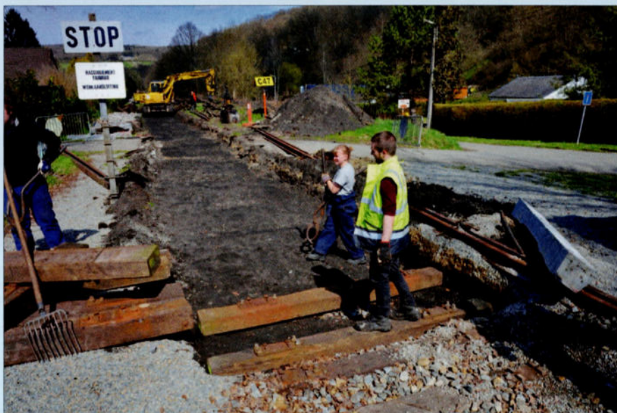
Te Bauche wordt het hoofdspoor vernieuwd en een wijkspoor aangelegd. CFB-TSP.
