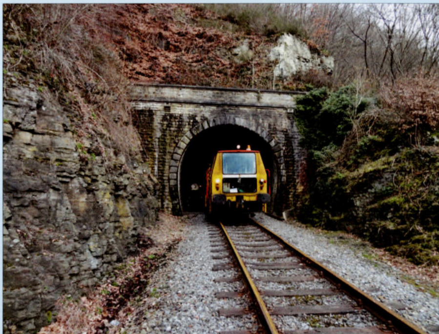
Onze onderstopper in actie aan de uitrit van de tunnel van Purnode op 24 maart. CFB-TSP.
