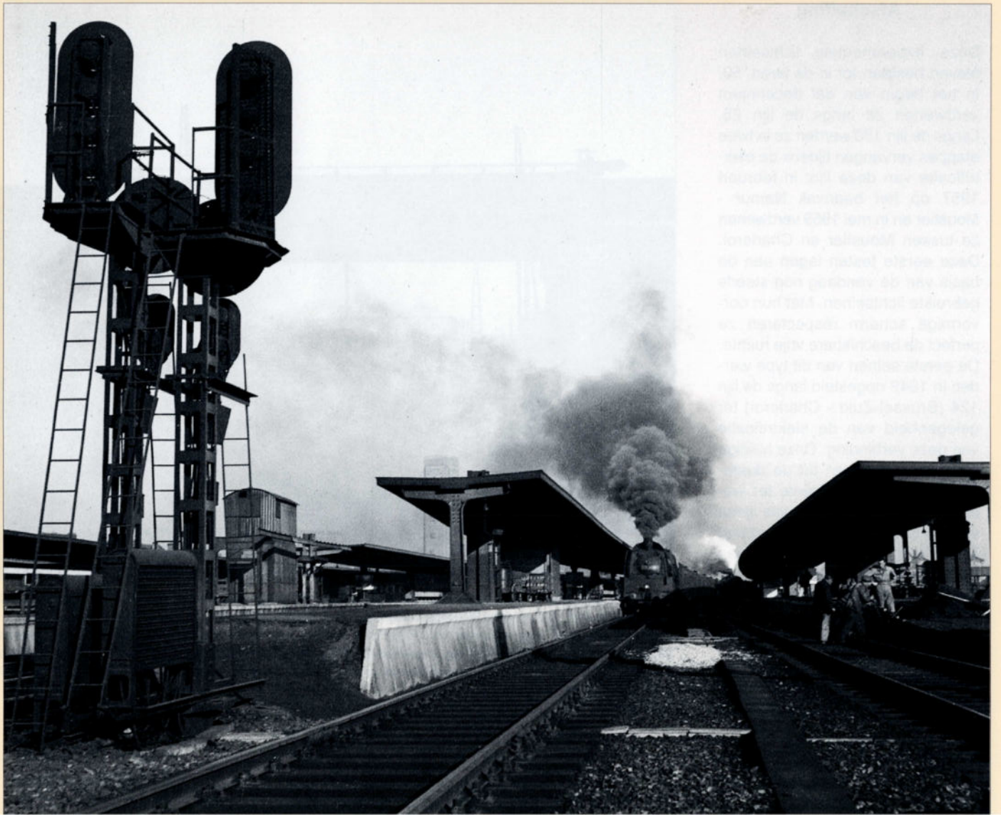
Een andere foto van het station Brussel-Zuid, waar de werken nog niet voltooid waren. Enkel het linkerdeel van het nieuwe station is al in dienst. Het niet zichtbare rechterdeel bevond zich nog op een lager niveau. Foto NMBS.
