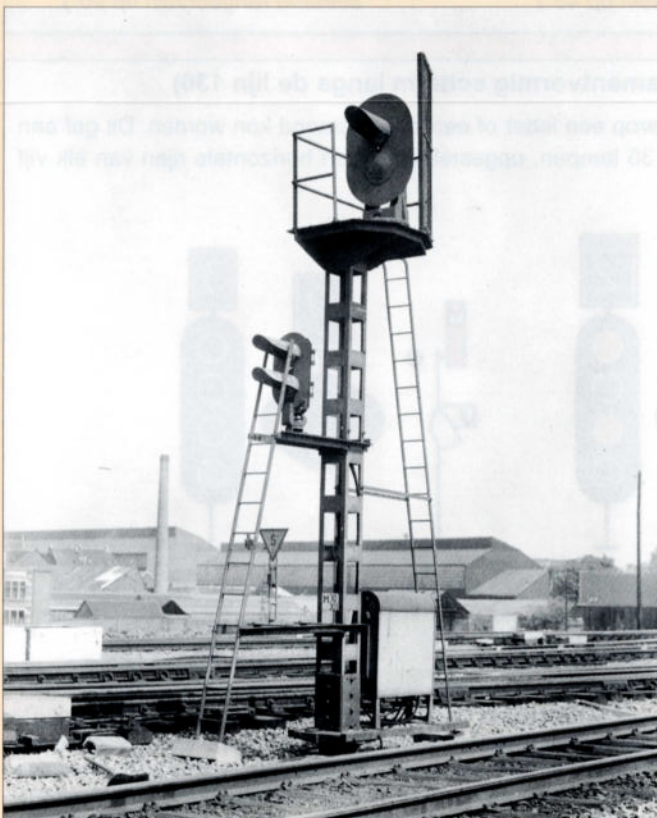
Een stopsein met een rangeersein in het station van Schaarbeek. Merk op dat het scherm van het stopsein enkel een rode lamp bevat. Het kan dus enkel geopend worden om een rangering toe te laten. Archief ACEC, verzameling Bois-du-Cazier.
