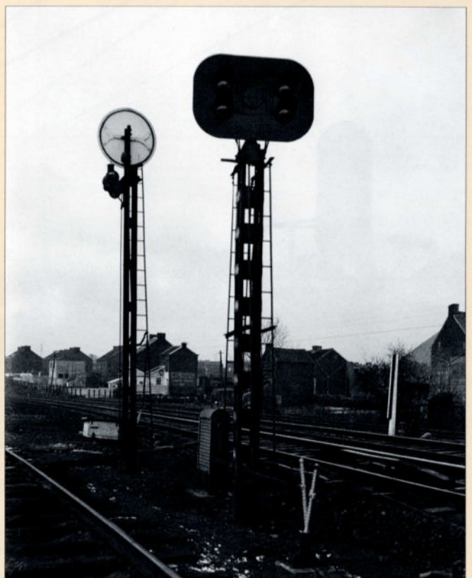
Nog een verwittigingssein met vier lampen langs de lijn 130. Achter het sein zien we de rugzijde van een oud sein met rode plaat. Foto NMBS.
