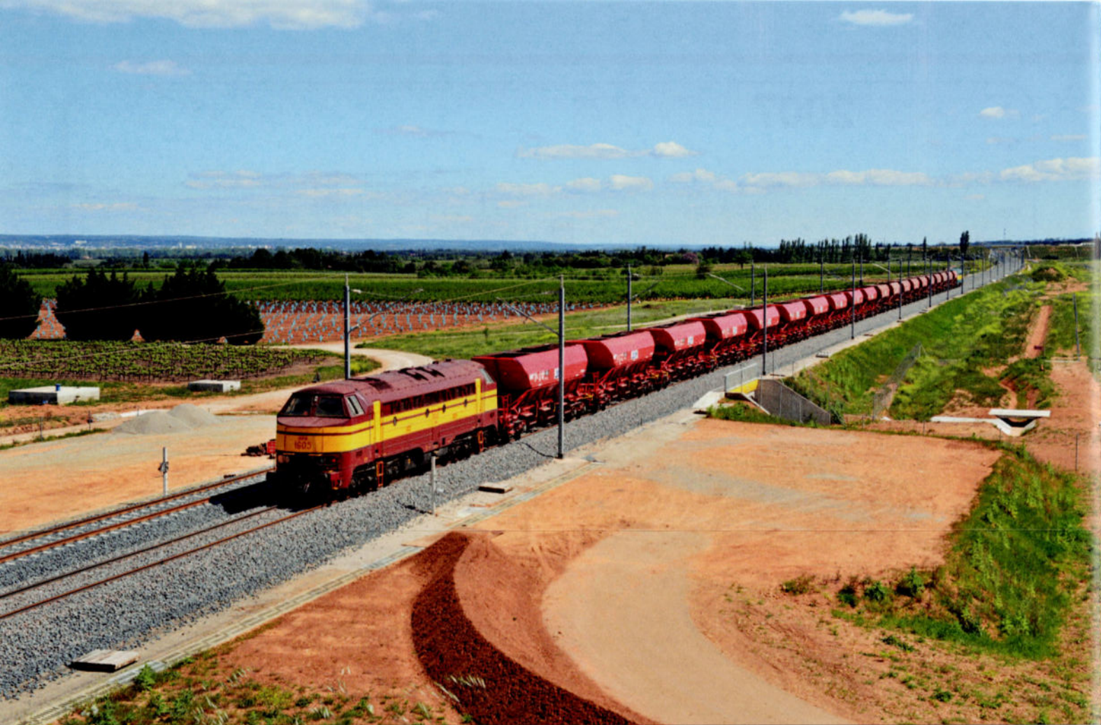
FOTO 134-27 Sinds het begin van de lente worden de vier voormalige locomotieven van de NMBS, de 5215, 5217, 7388 en 7389, eigendom van de maatschappij Somei en verhuurd aan de firma OCVIA (spoorwerken), ingezet bij de aanleg van de nieuwe HSL-lijn om de steden Nîmes en Montpellier (61 km) te omzeilen. Op 25 april 2016 zien we de 1605 (ex-5215) met een ballastrein in de omgeving van Aubord. De 5217 bevindt zich aan de andere zijde. Gwenaël PIERART.
