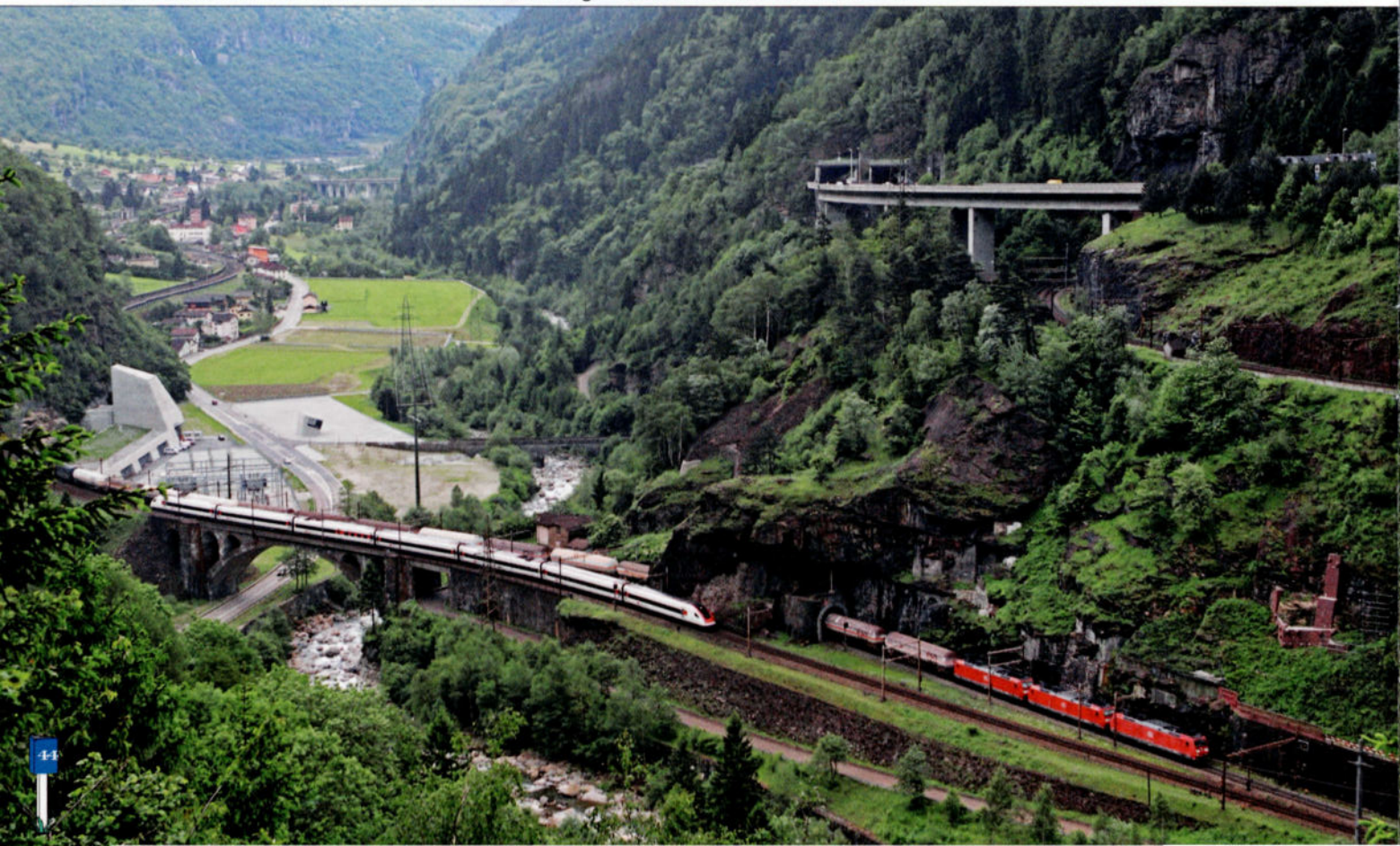
FOTO 135-52 Dezelfde plaats maar op 9 juni 2016 en gezien vanuit een ander standpunt. Op het laagste niveau kruisen twee treinen elkaar: een ICN-stel met bestemming Bellinzona en een goederentrein die wordt gesleept door drie locomotieven van de reeks 185 van de DB. Het tweede niveau bevindt zich boven de goederentrein. Michel HANSSENS.
