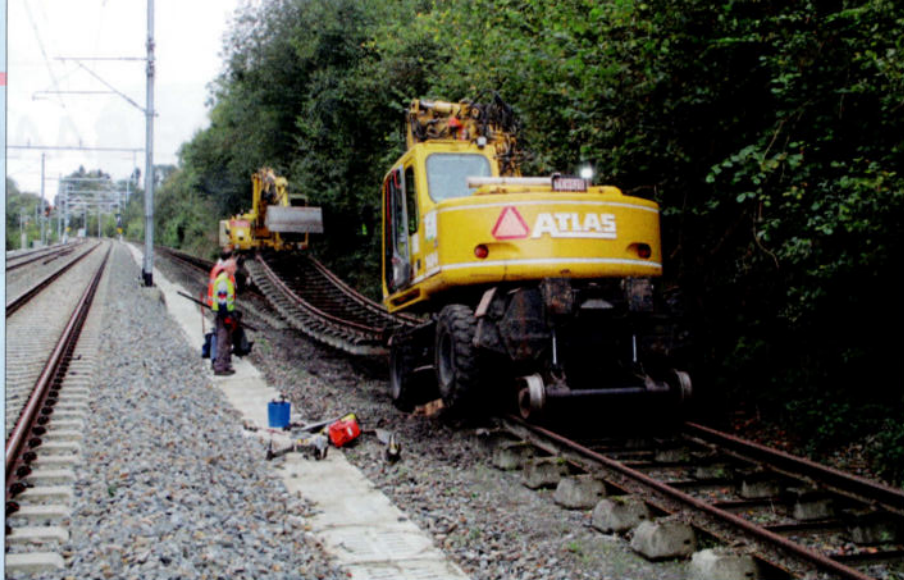
De spoorsegmenten werden één voor één aangebracht door twee kranen en achter elkaar geplaatst. Op deze foto zien we de aankomst van het laatste segment, 30 september 2016. TSP-CFB.
