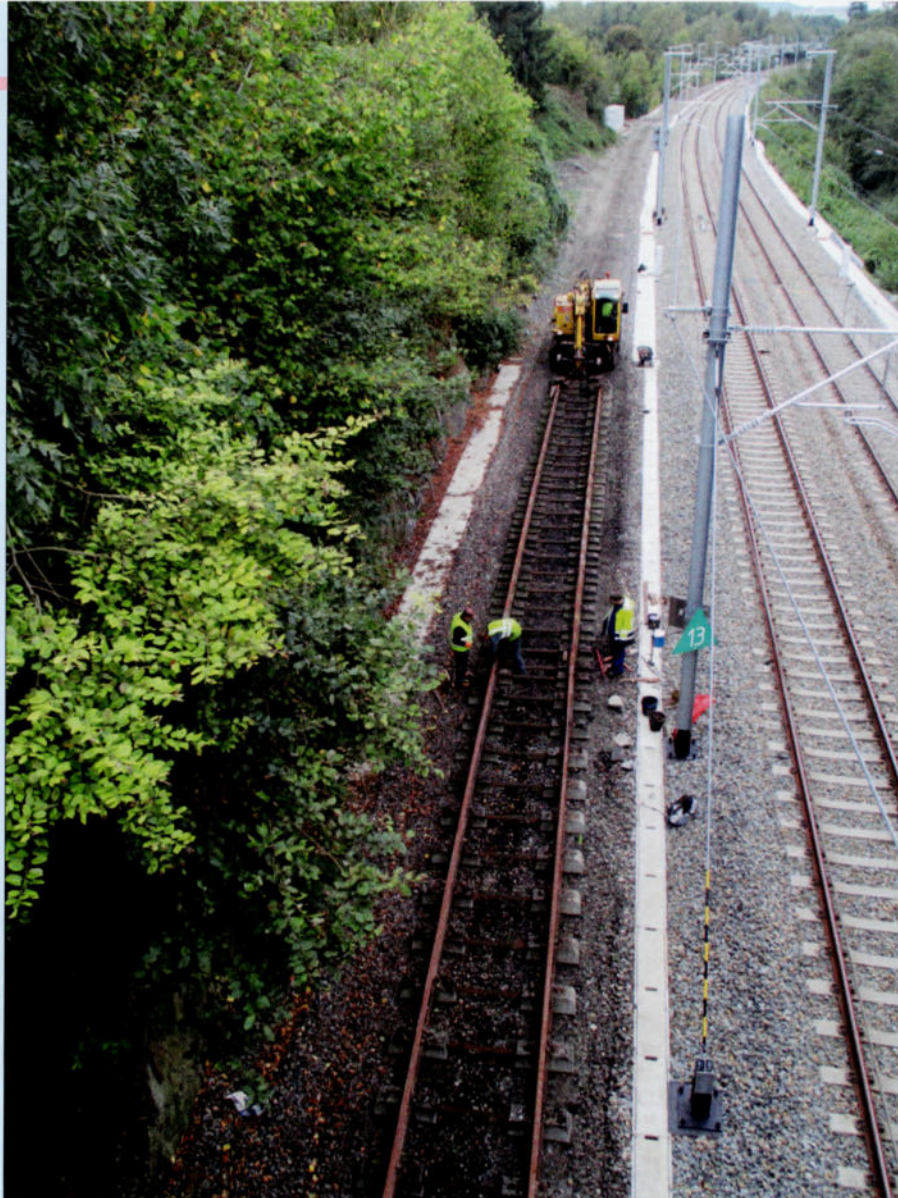
Elk spoorsegment werd teruggeplaatst in de volgorde waarin het gedemonteerd was. Daartoe had elk segment een nummer gekregen. Terwijl de beide kranen een nieuw segment gingen halen, maakte een ploeg vrijwilligers de lasplaten opnieuw vast. Dit enorm werk was heel goed voorbereid waardoor het mogelijk was om de 3 kilometer spoor in slechts twee weken tijd (een week in juni en een week in september) terug te plaatsen! Dit beeld is genomen vanaf de brug van Halloy op 27 september 2016. CFB-TSP.
