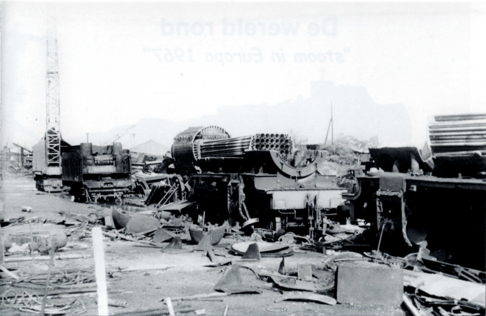
FOTO 136-61 Het stoomtijdperk is definitief voorbij. Het sloopwerk wordt voortvarend aangepakt, zoals hier bij de firma Heuvelmans te Antwerpen, waar twee 64'ers hun laatste uren beleven. Foto Hugo NAUWELAERTS, verzameling TSP.
