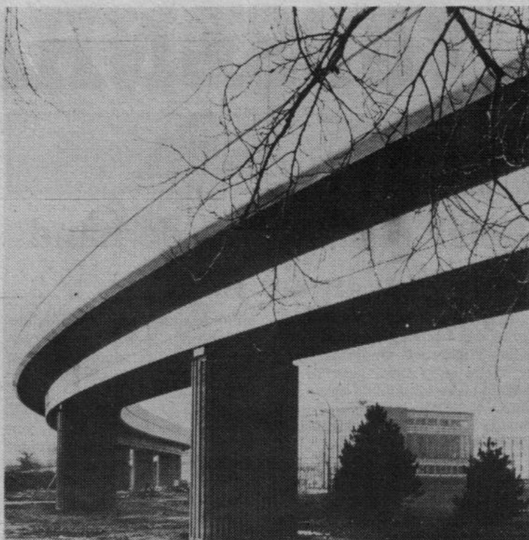
Een gedeelte van het traject van de VAL: een viadukt.
